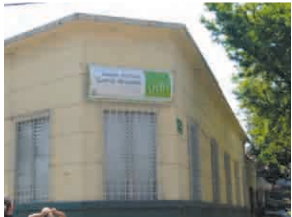
アラスデヌエボ (アンティオキア県) 外観
