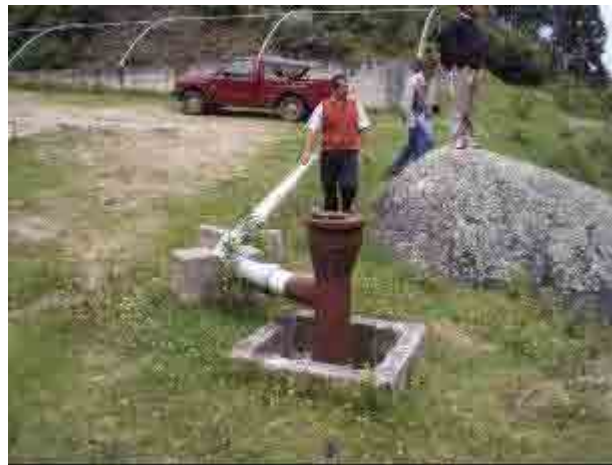
Lugar para el Proyecto Piloto ( Pozo del Acueducto) Fuente: Equipo de Estudio JICA
