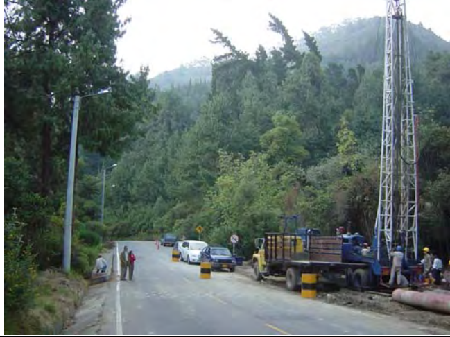
Trabajos de Perforación del Acueducto en La Aguadora; sitio candidato para un proyecto piloto futuro.
