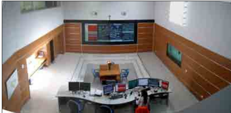
図 2.1- 35 写真：中央管理センター・中央監視室
