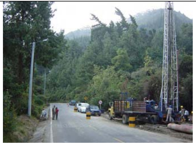
Acueducto が実施した La Aguadola 試掘井戸サイト。先行事業の予定サイトである。
