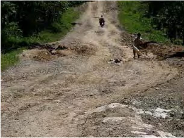
雨水による洗掘により路床まで損傷が進んでいる。
