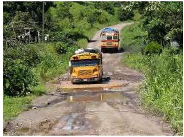
道路崩壊によって雨水が滞留し、バス等の車両通行に支障をきたす。
