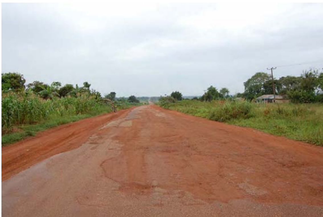
写真 3.1.1 道路の舗装劣化（北部回廊：Jinja-Bugiri 区間）
