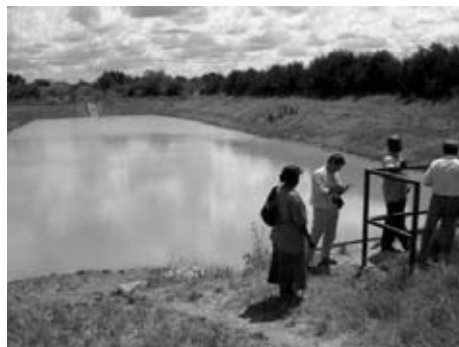
掘り込み式貯水池 (Nakasongola 県 Kitaleeda Valley Tank)
