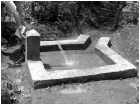
公共水栓（Kapchorwa 県 Kokwobutaki 村）
