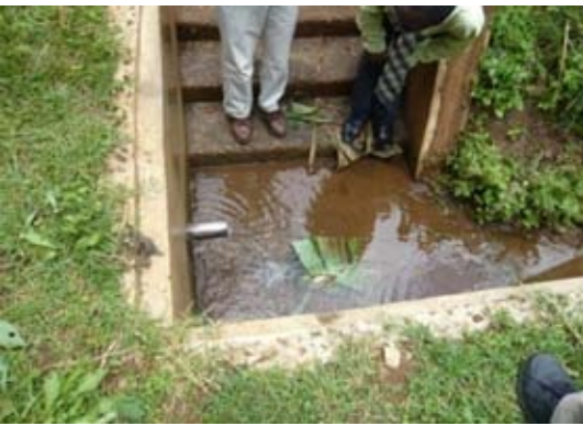
写-15：保護された泉（水量 2m³/h 程度、RUWASA プロジェクト）
