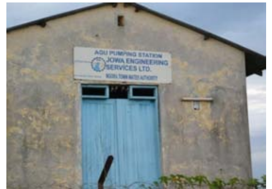
写-44 : 人口約 22,000 人の Ngola Town の水道水源である英国の援助による Agu ポンプ場 (1,300 m 3 /日?、ポンプ稼働 10 時間/日、水源は Agu 橋付近の表流水で Ngora Town 近くに浄水場がある。Ngora Town Water Authority が民間会社に運営を委託)
