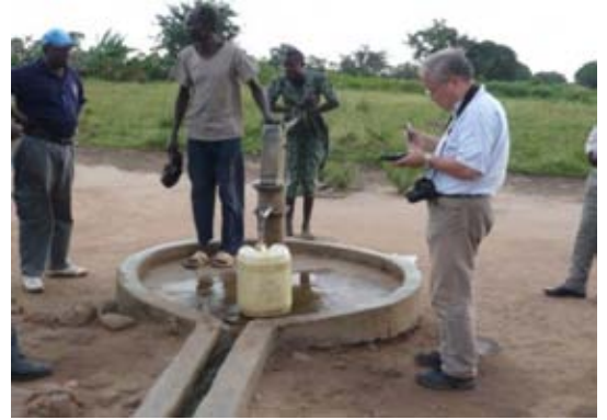
写-43 : Agu 橋付近 Agu 小学校傍のハンドポンプ設置深井戸 (深度 45m、表層はラライトで帯水層は花崗岩、水料金 1000Ush/世帯・年)
