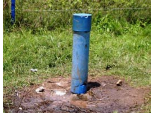
写-78 : 左記の井戸の拡大写真（人為的に破壊されたケーシングの割れ目から自然流出しており自噴井である。）
