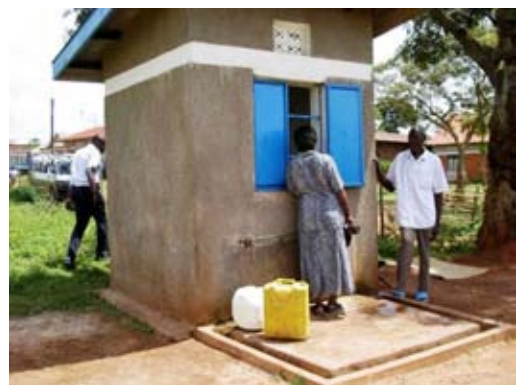
写-75 : キヨスク型公共水栓 (4 箇所ある。料金 100Ush/20L)
