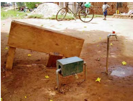
写-76 : 各戸給水の Yard Tap 型水栓 (68 箇所ある。料金 1,500Ush/m 3 )
