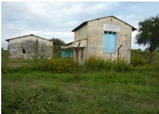
写-44 : 人口約 22,000 人の Ngola Town の水道水源である英国の援助による Agu ポンプ場 (1,300 m 3 /日?、ポンプ稼働 10 時間/日、水源は Agu 橋付近の表流水で Ngora Town 近くに浄水場がある。Ngora Town Water Authority が民間会社に運営を委託)
