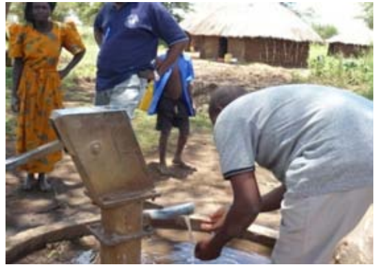
写-37 : Seretyo 橋付近の Ngenge sub-county 中心集落のハンドポンプ設置浅井戸(井戸深度 27 m、鉄の濃度が 1.5mg/l と WHO がイドライン値を越えている。この付近では 25 カ所の井戸があるが 15 カ所のみ稼働している。)
