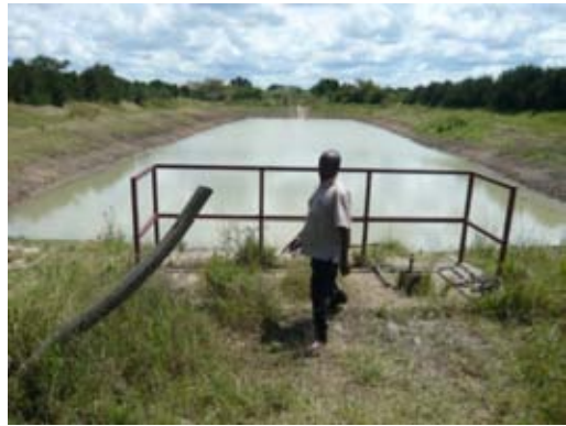
写-61 : Baleva valley tank (家畜用水の掘込み式の溜池で容量 100,000 lit. 洪水時は流入しない。位置 : Wajala 村)
