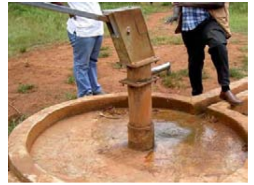
写-92 : カムリ Town 近郊の Namalemba 村のハンドポンプ設置深井戸 (1994 年建設、硝酸濃度が 60mg/l と高く家畜の糞尿や生活排水の汚染が考えられる。地表付近に硬質のラテライト層があるため柵が設置できない。カムリ県の平均的なハンドポンプの水料金は 2,000Ush/世帯 \cdot 年 。)
