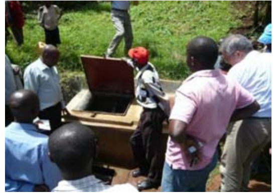
写-31 : 水源の保護された泉の取水口 (湧出量 1.6~2.0ℓ/s)
