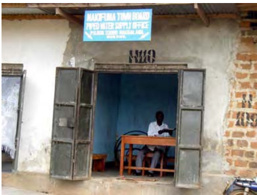
写-72 : Nakifuma Town のレベル II・III 給水施設を運営・維持管理している Nakifuma Town Board Piped Water Supply Office (2003 年の設計時には人口 7,000 人だったが、2008 年に 20,000 人になったとのこと)
