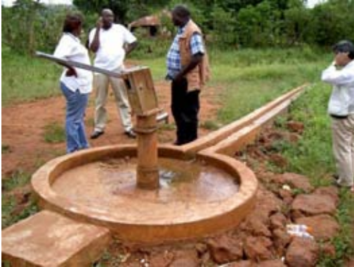
写-92 : カムリ Town 近郊の Namalemba 村のハンドポンプ設置深井戸 (1994 年建設、硝酸濃度が 60mg/l と高く家畜の糞尿や生活排水の汚染が考えられる。地表付近に硬質のラテライト層があるため柵が設置できない。カムリ県の平均的なハンドポンプの水料金は 2,000Ush/世帯 \cdot 年 。)
