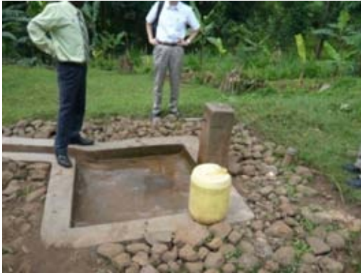
写-16 : Navisololo 村・重力式送水システムの公共水栓(水源：上流の保護された泉、50 家族が使用、1993 年 RUWASA プロジェクト設置)
