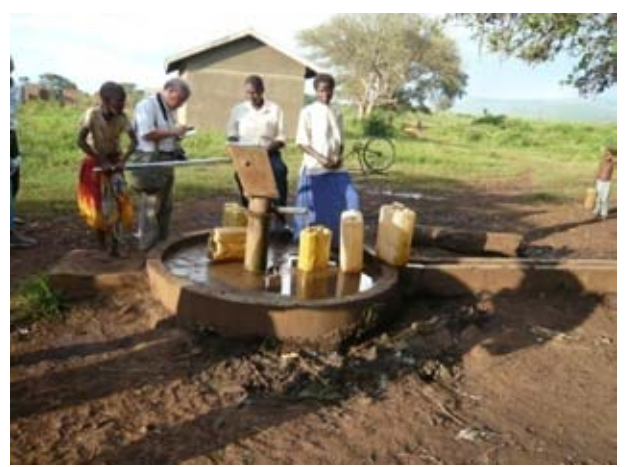
写-23 : シロンコ県平地部の深井戸(女の子がポンプを操作) Buyake School 傍、井戸深度 65m、India Mk-III ハンドポンプ
