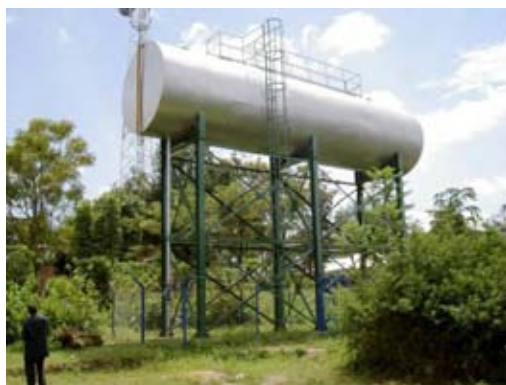
写-74 : Nakifuma Town の給水塔 (貯水容量 90m 3 、井戸は市街地にあり硝酸濃度が高く、生活排水に汚染されている可能性がある)
