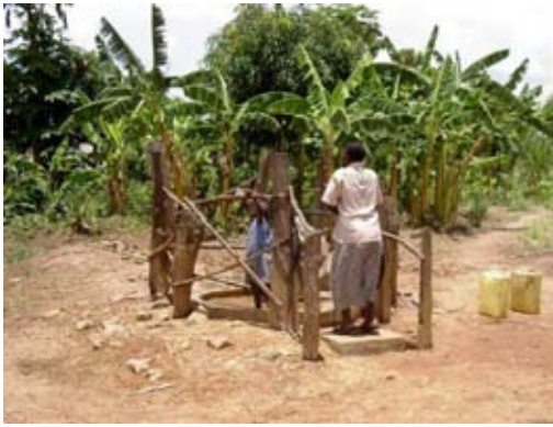
写-91 : Iyingo 村の小学校隣のハンドポンプ設置深井戸 (1992 年建設、付近に花崗岩の露頭がある。電気伝導度が 2,200 \mu S/cm と塩分濃度が高い。村には約 500 世帯あるが、ハンドポンプが 1 箇所しかないため、湖水の濁った水も飲んでいる。)
