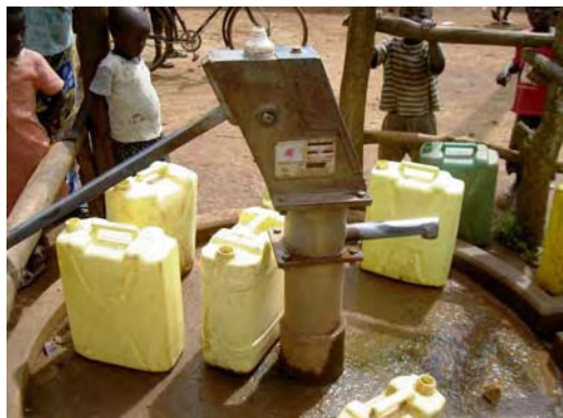
写-71 : Kibuye 村の 2005 年我が国無償によるハンドポンプ設置深井戸 (India Mk-II と U3 の部品が使われている。水料金は 1,000Ush/世帯・月、建設時に 100,000Ush を銀行口座に入れたものが維持)
