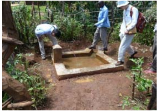
写-33 : 公共水栓 (写-32 のタンクから 9 箇所の公共水栓に配水) 水栓ごとの Tap Committee が運営・維持管理している
