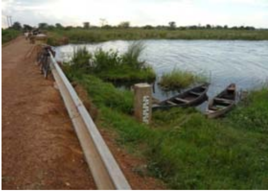
写-42 : Agu 橋 (洪水により橋の取付部が滞水し通行不可となったため盛土を実施。橋上流側 : 右側に量水標あり。2 回/日・水位測定)
