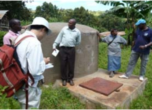
写-32 : 給水タンク (1998 年建設、容量 8,000ℓ、600 人に供給) 給水施設全体は Management Committee が運営・維持管理 している
