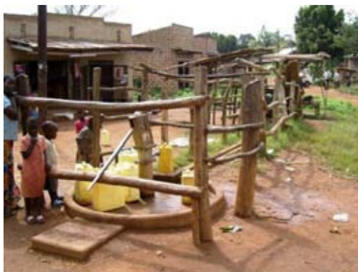
写-70 : Kyampisi Sub-county, Kibuye 村の 2005 年我が国無償によるハンドポンプ設置深井戸 (村の規模は 150 世帯で他に小さな泉が 1 箇所ある。柵がしっかりしており、排水も良好。)
