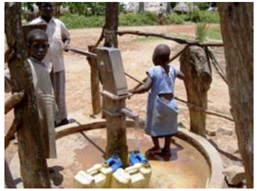
写-91 : Iyingo 村の小学校隣のハンドポンプ設置深井戸 (1992 年建設、付近に花崗岩の露頭がある。電気伝導度が 2,200 \mu S/cm と塩分濃度が高い。村には約 500 世帯あるが、ハンドポンプが 1 箇所しかないため、湖水の濁った水も飲んでいる。)
