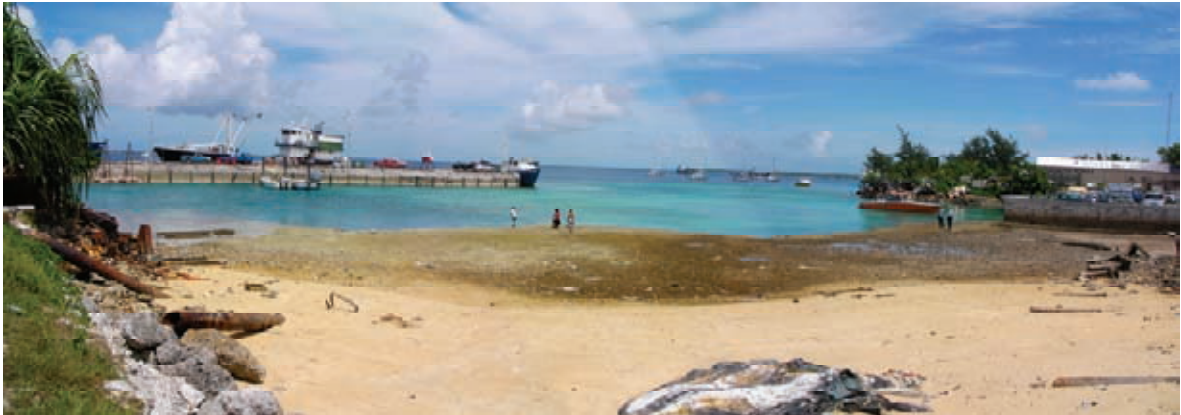
写真-1 計画サイトは、主に島間連絡船が利用するウリガ栈橋（写真奥）に隣接する潮間帯に位置しており、施設建設にあたっては、干潟部分を埋め立ててサイト造成を行う必要がある。リーフエッジ付近が係船岸となる。
