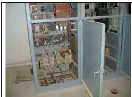
Панель Управления для насосов
