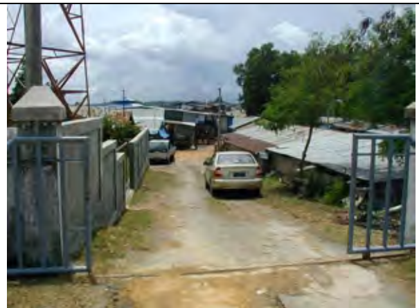
写真 3-6： 沿岸無線局入り口（一般道から車両により敷地内に入ることが可能であるが、民家が隣接しており狭い。
