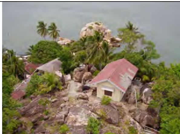
写真 1-3: レーダー/通信鉄塔建設予定地 (写真中央やや右の建物は既設発電機棟。鉄塔建設予定地は写真手前。)
