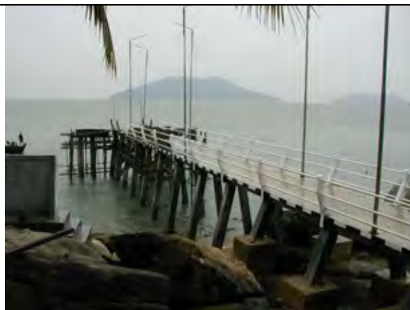
写真 1-6: 既設栈橋 (島内で働いている灯台職員、国境警備員の移動、補給燃料・生活物資等の運搬用で、小型船向け施設である。)
