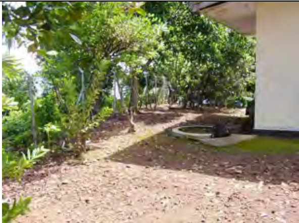
写真 2-3: 発電機棟建設予定場所 (既設フェンスは先方政府負担により移設。)
