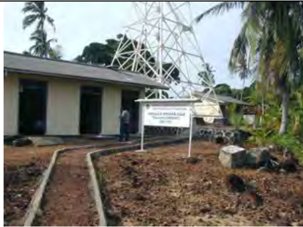
写真 4-1: タンジュン・ブラキットのサイト入り口（既存灯台があり、その運営施設が置かれている。）
