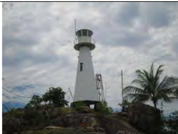
写真 1-2: ヒュー・クチール既設灯台 (オランダ統治時代からの灯台で、建造は 1888 年とある。)
