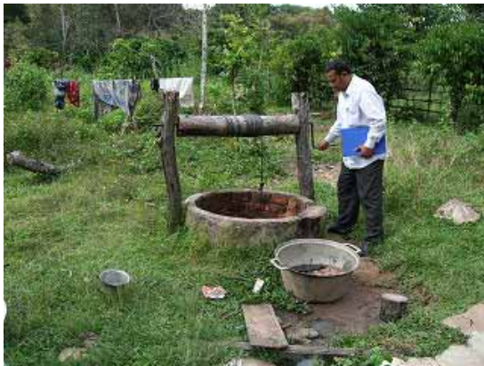
写真-3：給水状況（Sambour 村） 巻上げ式の掘抜き井戸。
