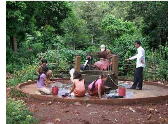
写真-4：給水状況（Ta Kaev 村） つるべ式の掘抜き井戸。婦女子にとっては、水汲みが重労働となっている。
