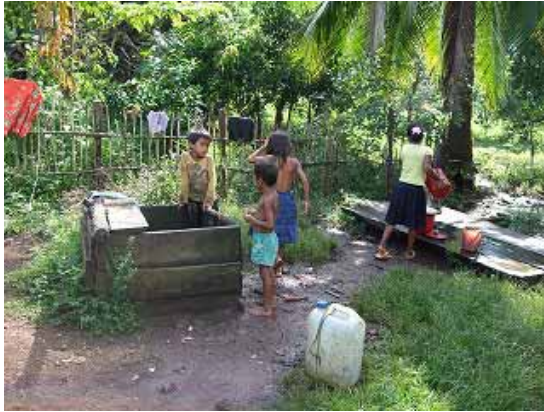
写真-1：給水状況（Robang Chroh 村） 調査対象村落において一般的に見られる掘抜き井戸（浅井戸）である。
