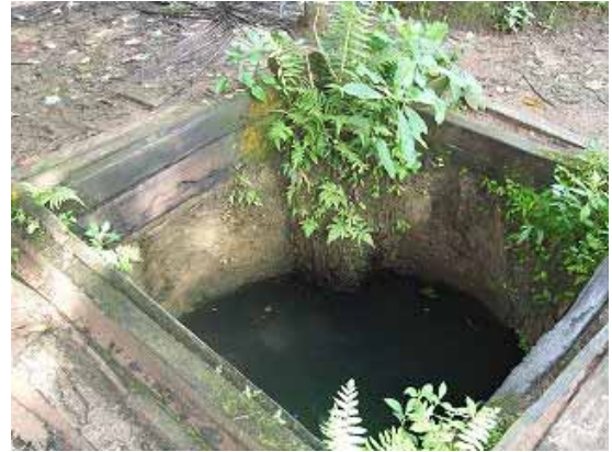
写真-2：給水状況（Kambas 村） 掘抜き井戸は、木製の枠で囲ったものがあるが、雨期には汚水が流れ込むため不衛生である。
