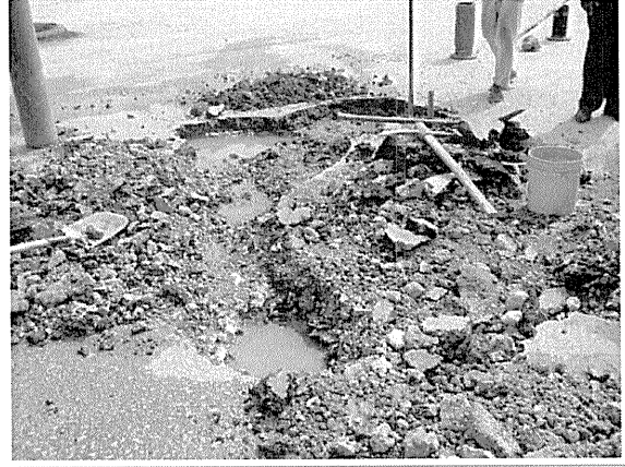
ザンジバル水公社スタッフによる漏水修理現場（タンザニア）
