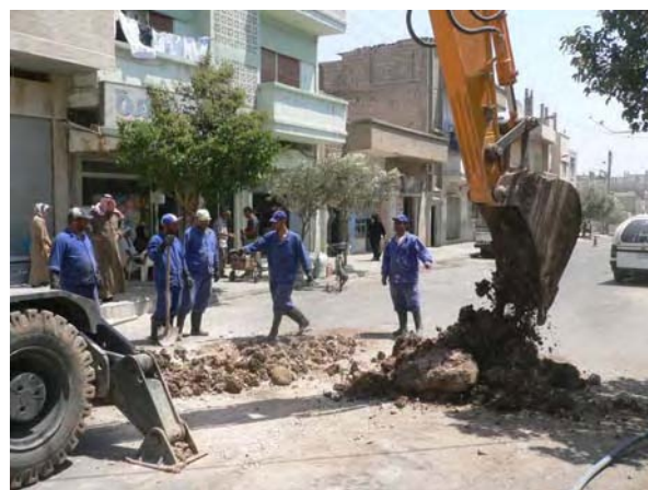
写真 D-2 ホムス市内における管渠清掃現場 （閉塞が解消されず管渠を掘り出して清掃を続行することに）
