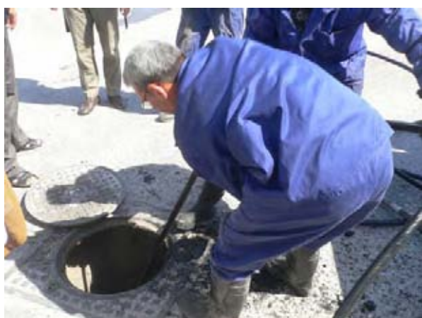
写真 B-1 管渠の清掃現場 1 ( 高圧洗浄車によりマンホール内を清掃中 )
