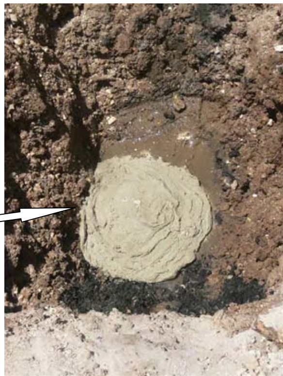
写真 2-9-3 ホムスでの管渠清掃現場 (管渠を掘り出して削孔後、堆積物を除去。作業終了後、石とモルタルで蓋をしてそのまま埋戻す。)
