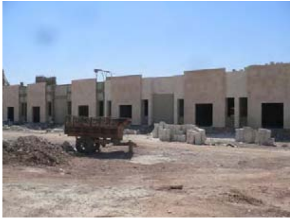
写真 A-1 ハマトレーニンセンター 研修施設 (建設中)
