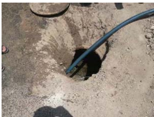
写真 D-1 ホムス市内における管渠清掃現場 （マンホールから閉塞の解消を試みる）
