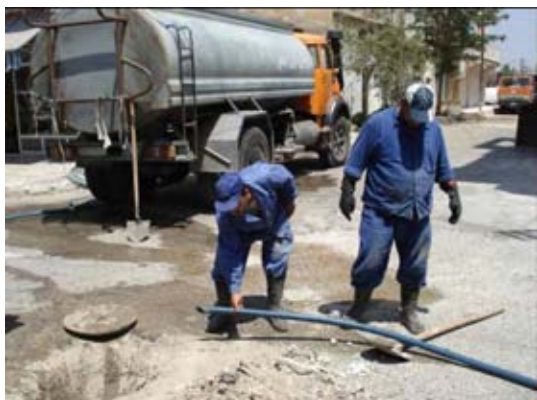
写真 1-8-4 給水ホースの先端（洗浄用ノズルなどは付けられていない）
