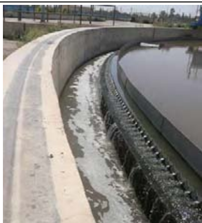
写真 B-11 アドラ下水処理場 （最終沈殿池：処理水の様子）
