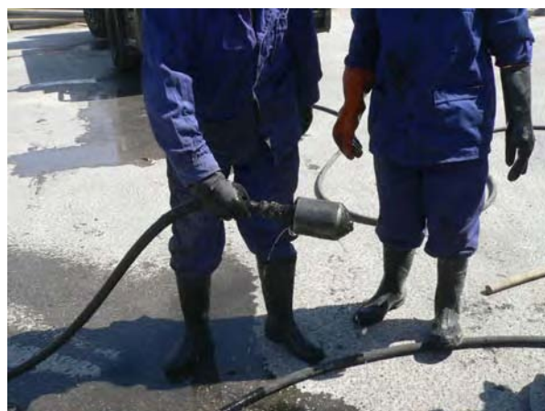
写真 B-2 管渠の清掃現場 1 ( 洗浄に使用していたノズル )
