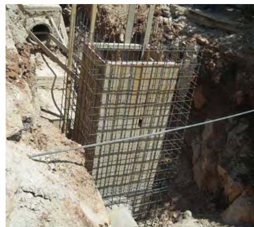
写真 A-6 ガーブ地区 幹線管渠建設現場 (マンホールを建設中)
