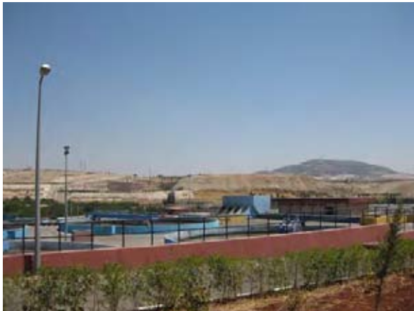
写真 A-3 ハマ下水処理場 (水処理施設)
