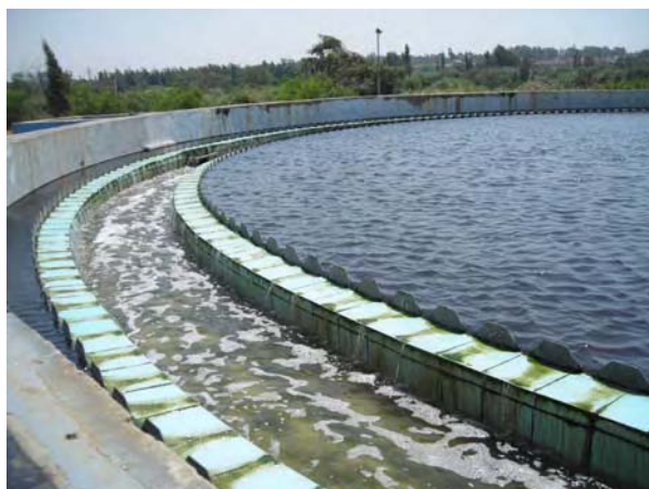
写真 D-6 ホムス下水処理場 （最終沈殿池：処理水の様子）
