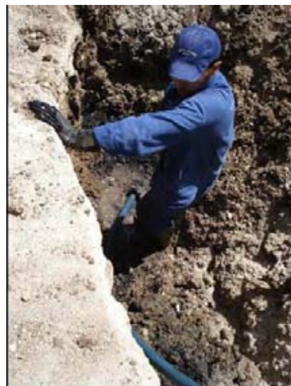
写真 1-8-6 下水管渠の上面に穴を開ける様子 写真 1-8-7 下水管渠の上面に開いた穴から給水する様子
