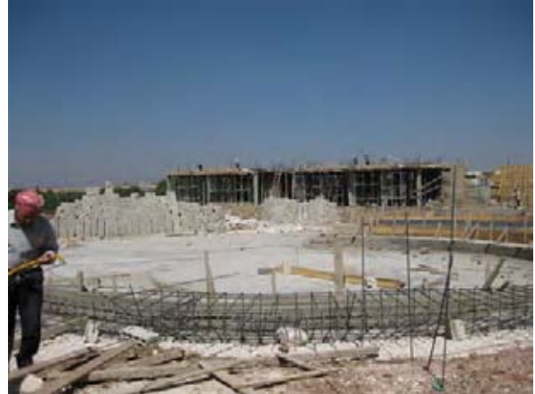
写真 A-2 ハマトレーニンセンター シアター (建設中)
