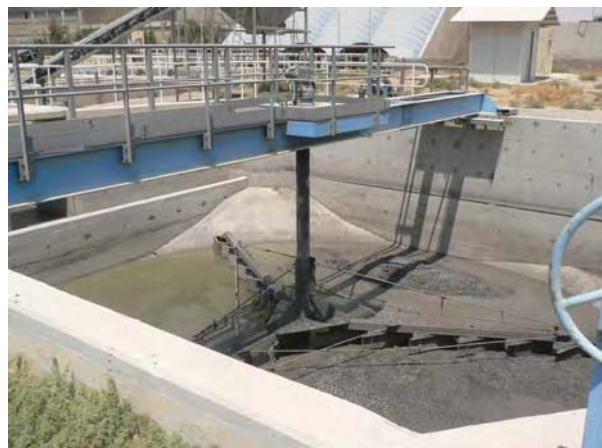
写真 B-8 アドラ下水処理場 （沈砂池）
