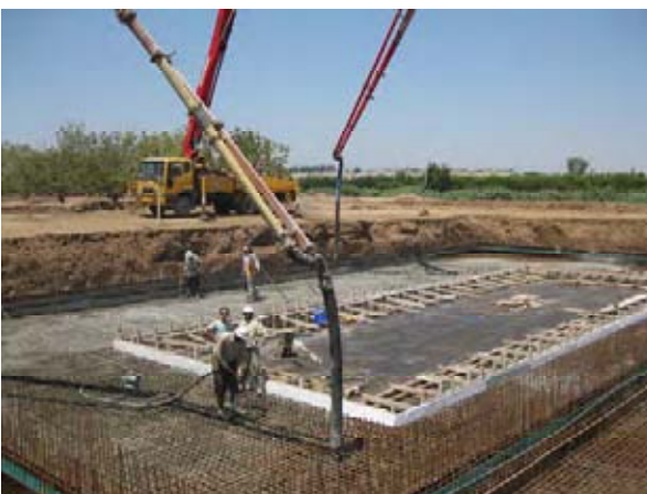
写真 A-5 ハルデ下水処理場 反応槽 (建設中)
