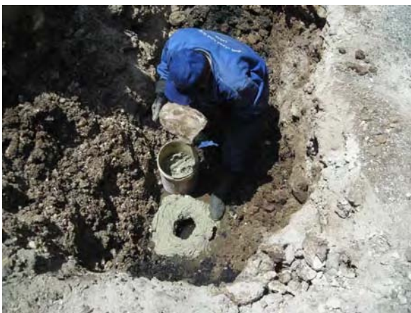
写真 D-3 ホムス市内における管渠清掃現場 （閉塞が解消され削孔した管渠に蓋をしている）
