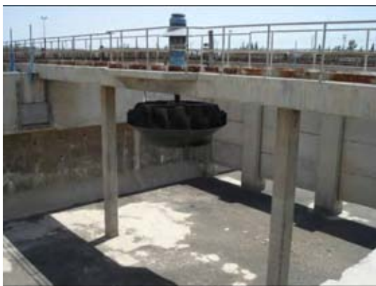
写真 1-8-8 空になっている曝気槽と表面攪拌装置
