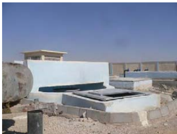
写真 C-2 ダマスカス郊外県にて建設中の下水処理場 （最終沈殿池）
