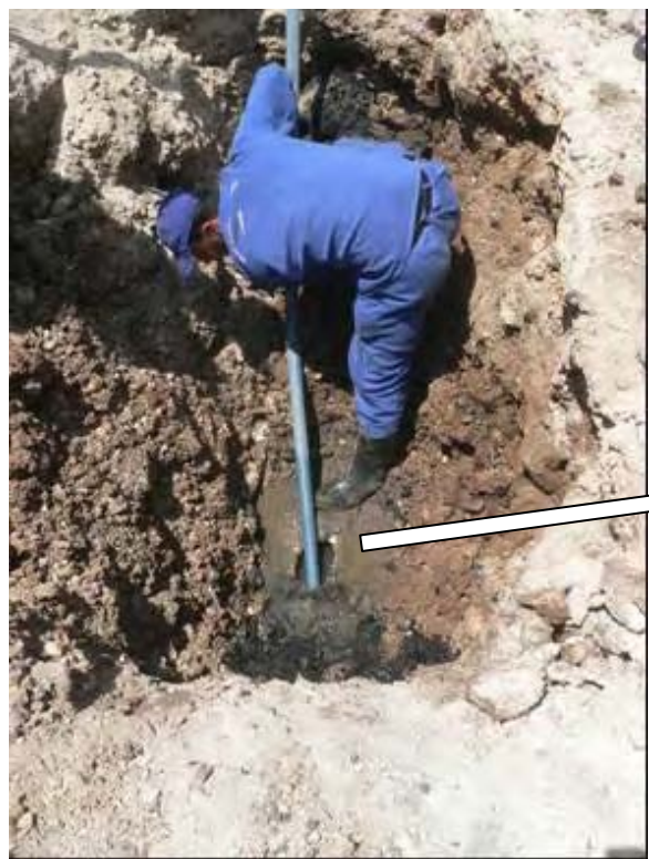
写真 2-9-3 ホムスでの管渠清掃現場 (管渠を掘り出して削孔後、堆積物を除去。作業終了後、石とモルタルで蓋をしてそのまま埋戻す。)
