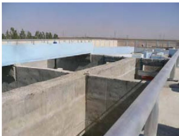
写真 C-1 ダマスカス郊外県にて建設中の下水処理場 （反応槽）
