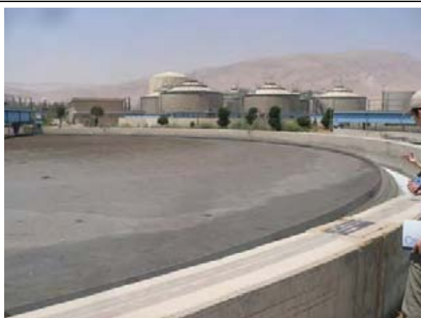
写真 B-9 アドラ下水処理場 （最初沈殿池）
