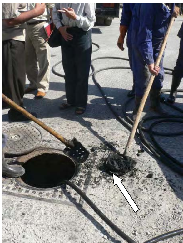
写真 2-9-1 ダマスカでの管渠清掃現場 (拳大の石が混入)
