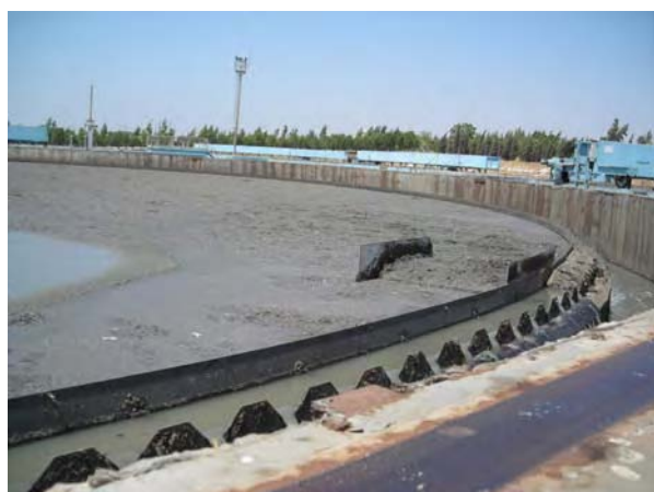
写真 D-5 ホムス下水処理場 （最初沈殿池）
