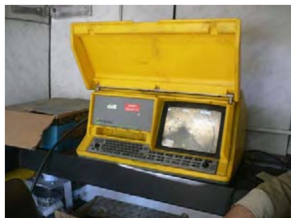
写真 B-4 管渠の清掃現場 2 ( 自走式かきによる管渠内の映像 )
