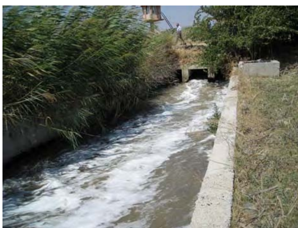
写真 D-7 ホムス下水処理場 （放流水路）
