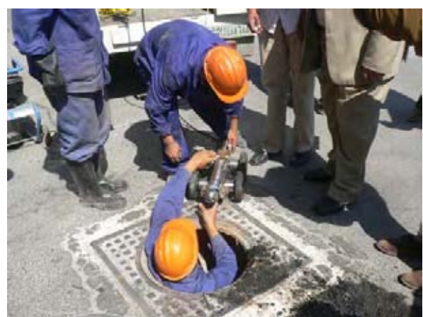
写真 B-3 管渠の清掃現場 2 ( 自走式かきによる管渠の点検 )
