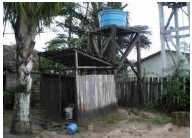
Departamento de Pando 143 Primero Mayo Caseta del pozo y deposito elevado
