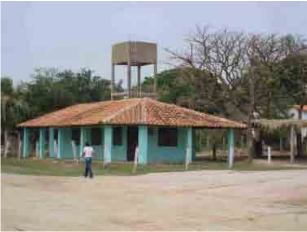
Departamento de Beni Verdum Tanque elevado hecho de hormigon armado
