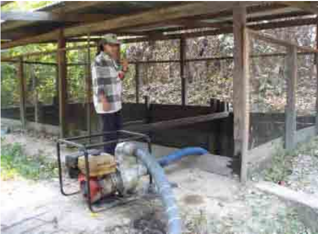
Departamento de Pando 065 Puerto Rico Captacion de agua del deposito del estanque
