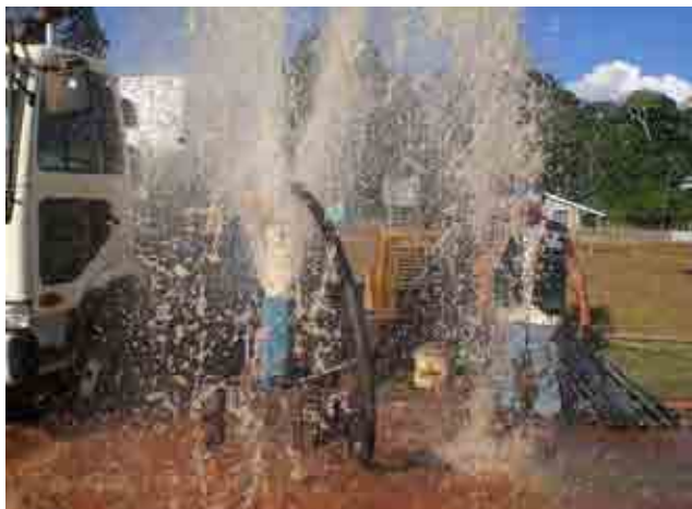
Sondeo Lavado del pozo con el aire comprimido
