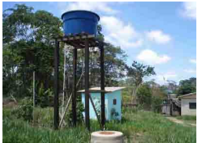
Departamento de Pando 007 Santa Rita Pozo redondo y deposito elevado
