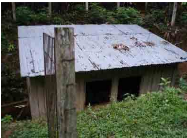
Departamento de Pando 050 Filadelfia Caseta de captacion de agua de arroyo
