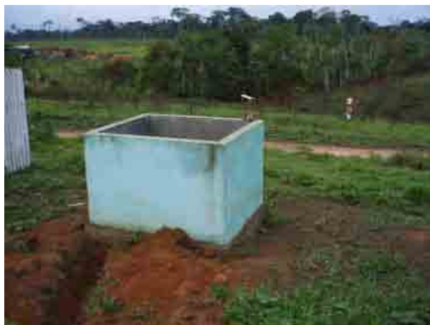
Departamento de Pando 053 Empresina Tanque en construccion
