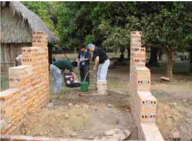
Departamento de Beni 038 San Pedro Pozo equipado de una bomba manual
