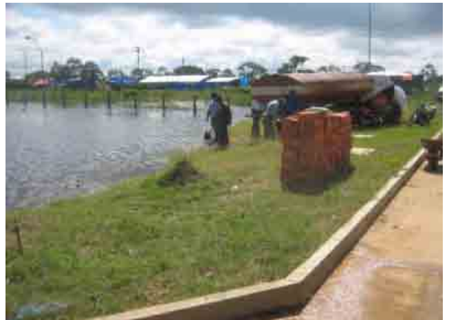
Planta de tratamiento de agua del Municipio de Trinidad, Departamento de Beni Parte inundada por el desborde el rio
