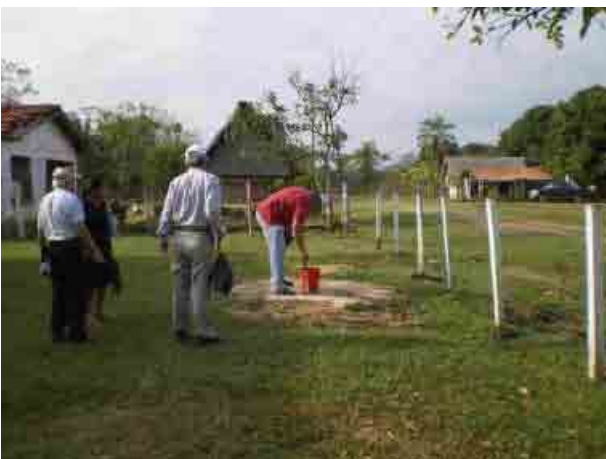
Departamento de Beni 150 Villa Banzer Pozo equipado de bomba manual
