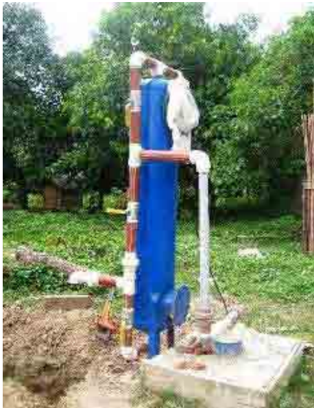
Proyecto piloto (Puerto San Borja, Departamento de Beni) Filtro para eliminar manganeso
