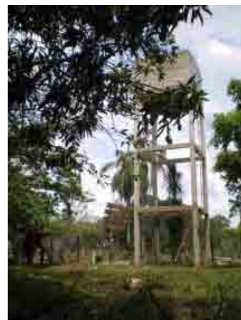
Departamento de Beni 146 San Andres Tanque elevado hecho de hormigon armado
