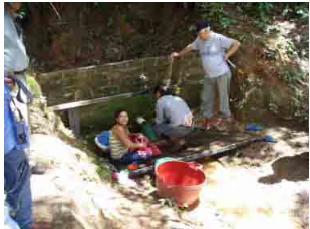
Departamento de Pando 105 Gonzalo Moreno Dique de captacion de agua en una vertiente
