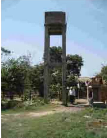
Departamento de Beni 008 Puerto Varador Tanque elevado hecho de hormigon armado
