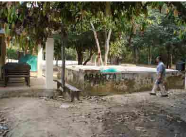
Departamento de Beni Verdum Bomba manual instalada en un deposito
