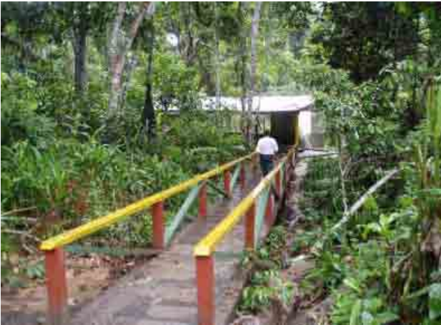
Departamento de Pando 118 Sena Instalaciones de captacion de agua en un arroyo
