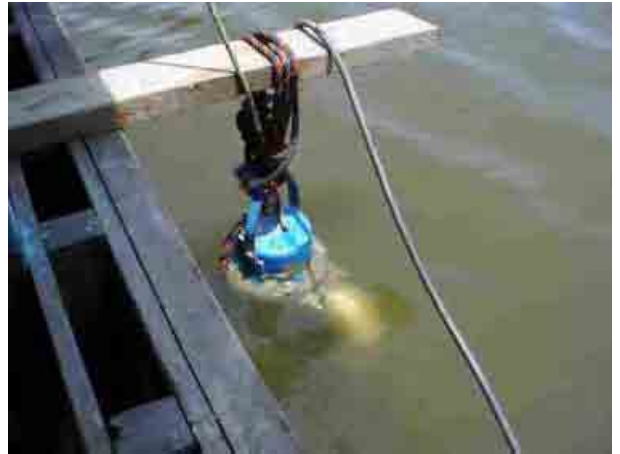
Planta de tratamiento de agua del Municipio de Santa Ana, Departamento de Beni Bomba de captacion de agua
