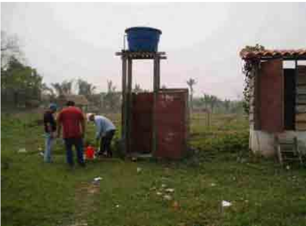
Departamento de Beni 143 Nueva Creacion de Cotoca Deposito elevado, ducha, letrina y llave
