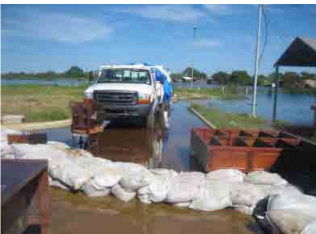
Planta de tratamiento de agua del Municipio de Trinidad, Departamento de Beni Parte inundada por el desborde el rio
