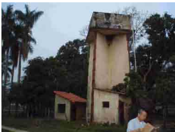
Departamento de Beni 005 Casarabe Tanque elevado hecho de hormigon armado
