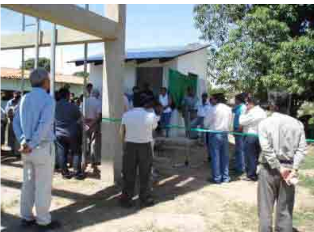
Instalaciones piloto Tanque y caseta de control
