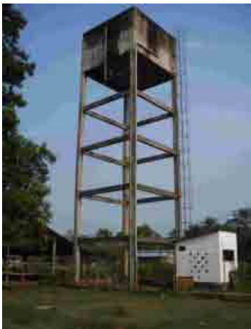
Departamento de Beni 068 La Embocada Tanque elevado hecho de hormigon armado
