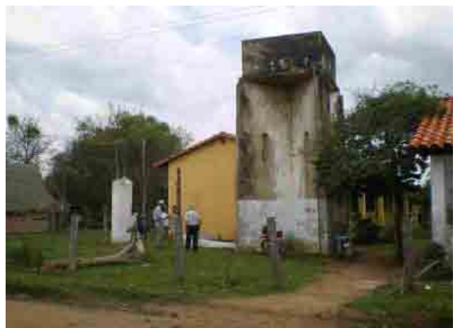
Departamento de Beni 144 Peroto Tanque elevado hecho de hormigon armado
