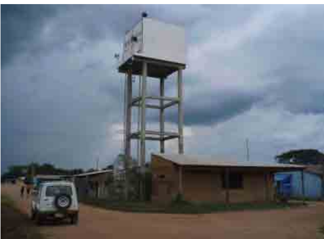
Departamento de Beni 145 Puente San Pablo Tanque elevado hecho de hormigon armado
