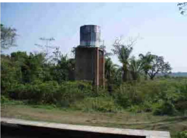
Planta de tratamiento de agua del Municipio de San Ignacio, Departamento de Beni Tanque elevado para el uso interno de agua en la planta
