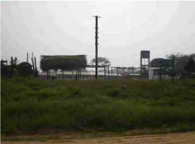
Departamento de Beni_045 Nuevos Horizontes Tanque elevado hecho de hormigon armado contiguo a una escuela primaria
