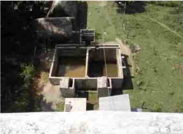
Planta de tratamiento de agua de la comunidad de Peru, Departamento de Beni Vista general de la planta de tratamiento de agua
