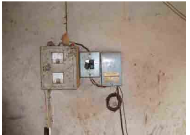
Departamento de Beni 201 12 de octubre Panel de control para una bomba sumergible
