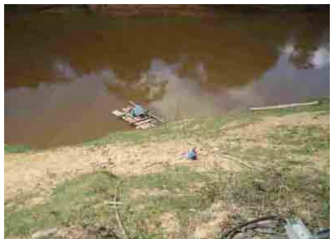
Planta de tratamiento de agua de la comunidad de Peru, Departamento de Beni Bomba de captacion de agua del rio
