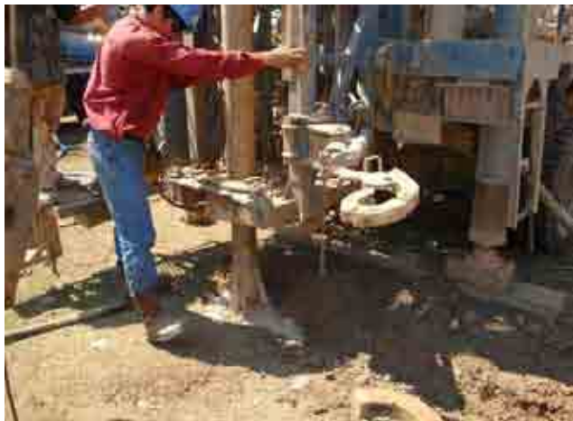
Sondeo Inicio de la perforacion
