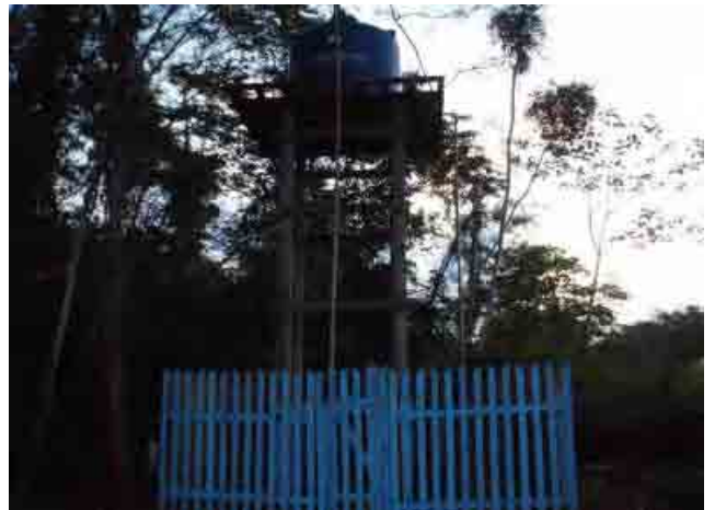
Departamento de Pando 066 Batraja Deposito elevado
