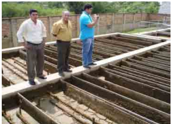
Recorrido por las instalaciones existentes
