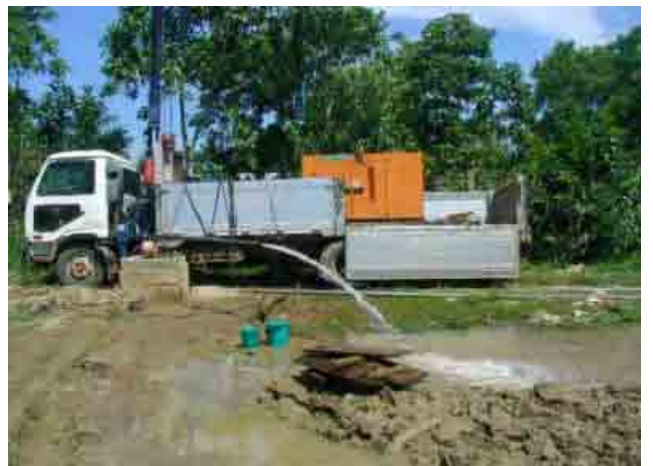
Sondeo Prueba de bombeo continuo por las 24 horas
