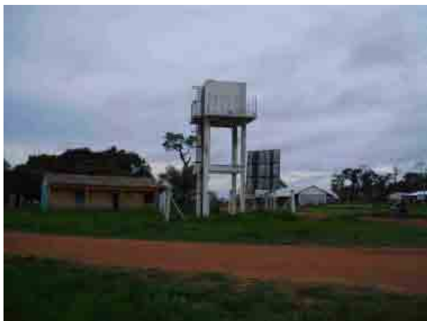
Departamento de Pando 050 Filadelfia Tanque elevado hecho de hormigon armado
