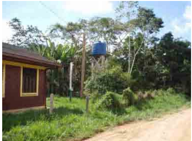
Departamento de Pando 026 Alta Bahia Deposito elevado
