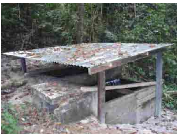
Departamento de Beni 083 Yucumo Captacion de un rio
