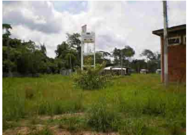
Departamento de Pando 044 Cachelita Boja Tanque elevado hecho de hormigon armado
