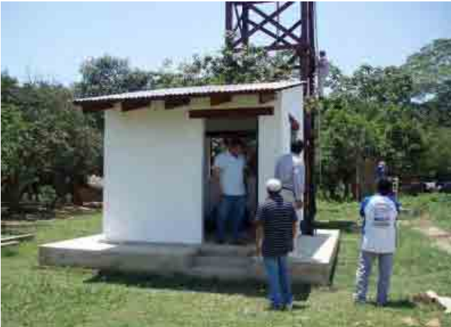
Proyecto piloto (Puerto San Borja, Departamento de Beni) Caseta de control
