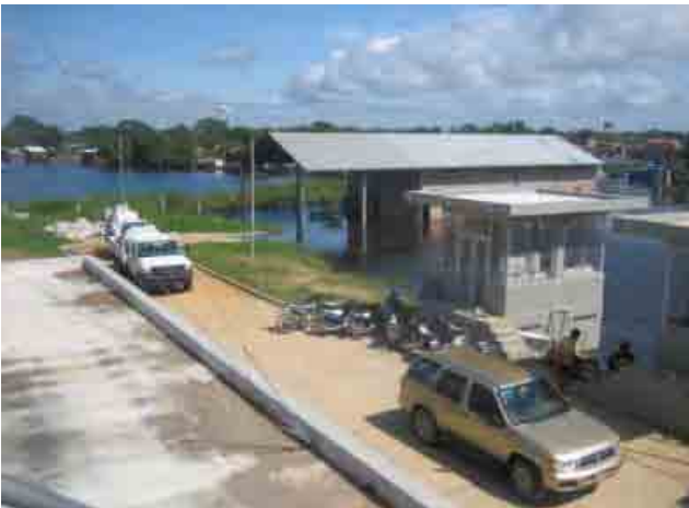
Planta de tratamiento de agua del Municipio de Trinidad, Departamento de Beni Parte inundada por el desborde el rio y el almacen de la planta de tratamiento de agua
