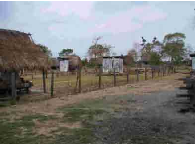
Departamento de Beni 113 Puerto Teresa del Yata Instalaciones sanitarias (letrina)
