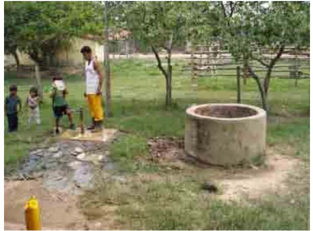
Departamento de Beni 148 Santa Rosa Pozo redondo con un pozo equipado de bomba manual al lado
