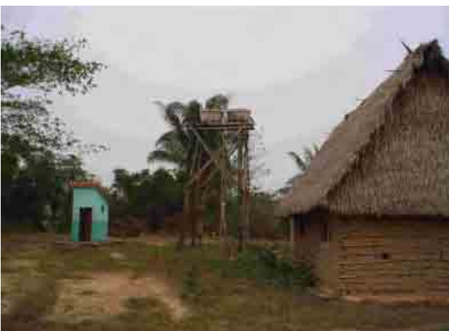
Departamento de Beni 041 Coacabana Instalaciones sanitarias (letrina) y tanque elevado
