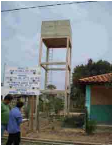
Departamento de Beni 003 San Javier Tanque elevado hecho de hormigon armado
