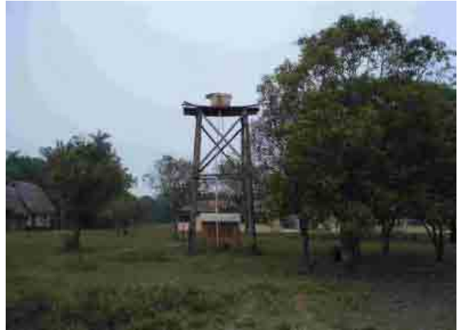
Departamento de Beni 035 Cosar Pozo y tanque elevado
