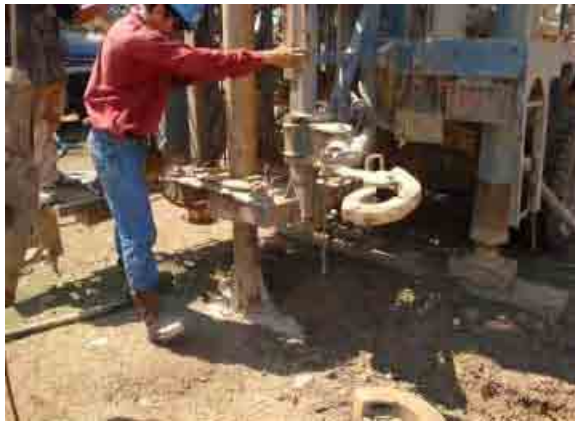
Estudio de perforacion de pozos Comienzo de perforacion
