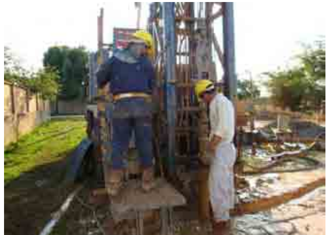
Sondeo Estado de perforacion
