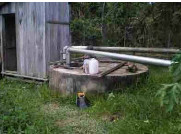
Departamento de Pando 035 Porvenir Pozo redondo y tubería de impulsión instalada
