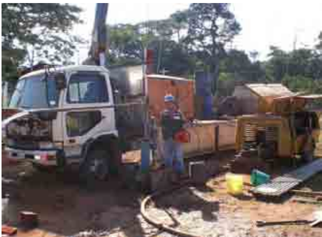
Sondeo Preparacion de prueba de bombeo
