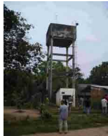
Departamento de Beni 065 Galilea Tanque elevado hecho de hormigon armado
