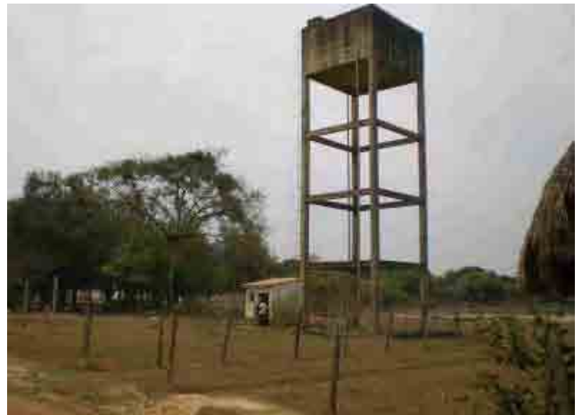
Departamento de Beni 109 Triunfo Tanque elevado hecho de hormigon armado
