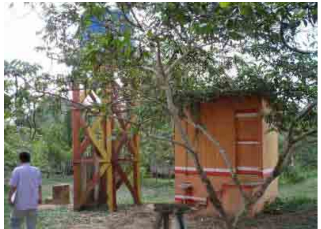
Departamento de Pando 030 Mejillones Deposito elevado e instalaciones sanitarias (letrina )
