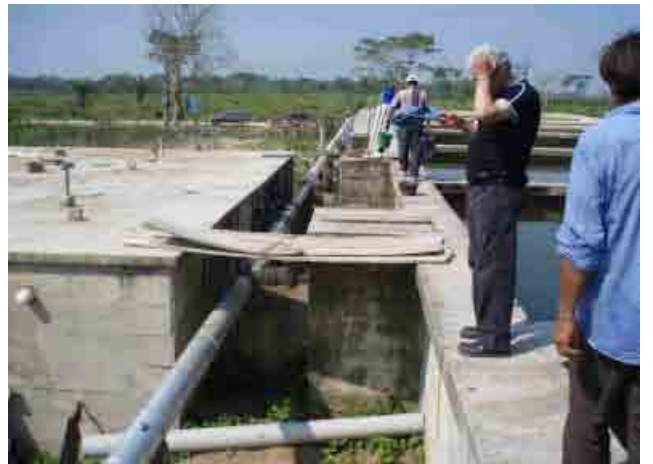
Planta de tratamiento de agua del Municipio de San Ignacio, Departamento de Beni Filtro lento y tanque de agua tratada
