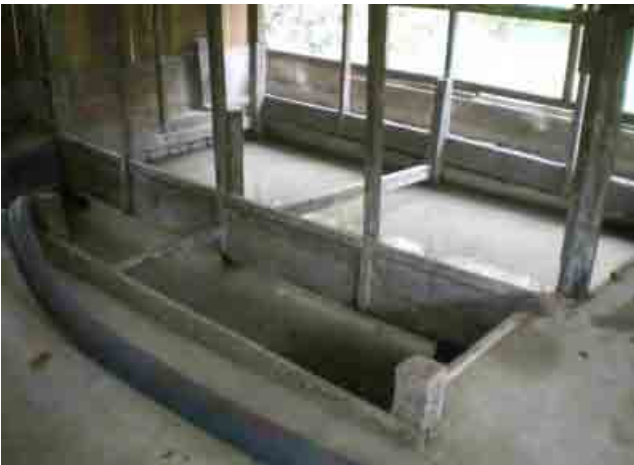
Departamento de Pando 075 Avarora Interior del deposito del estanque
