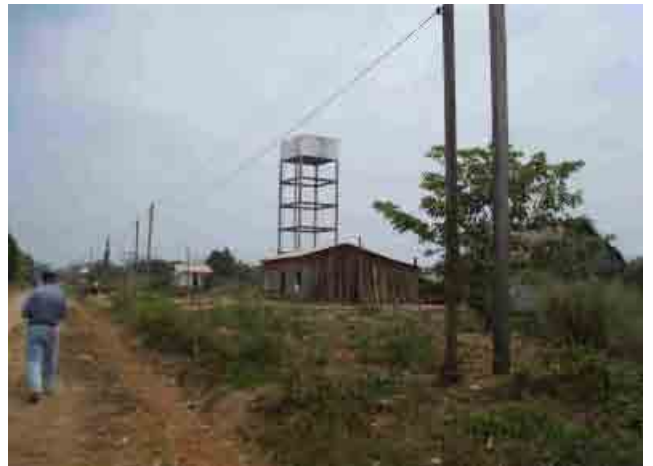
Departamento de Pando 065 Puerto Rico Tanque elevado hecho de hormigon armado
