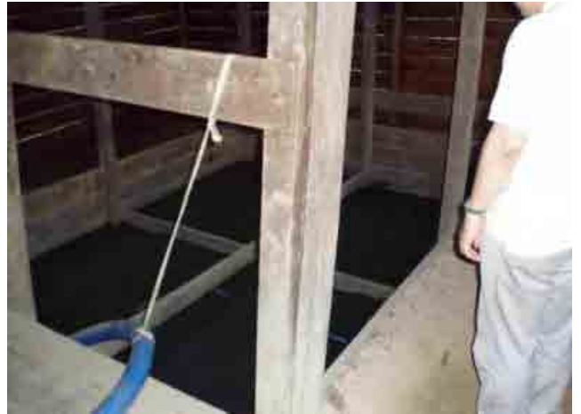
Departamento de Pando 066 Batraja Captacion de agua del deposito del estanque
