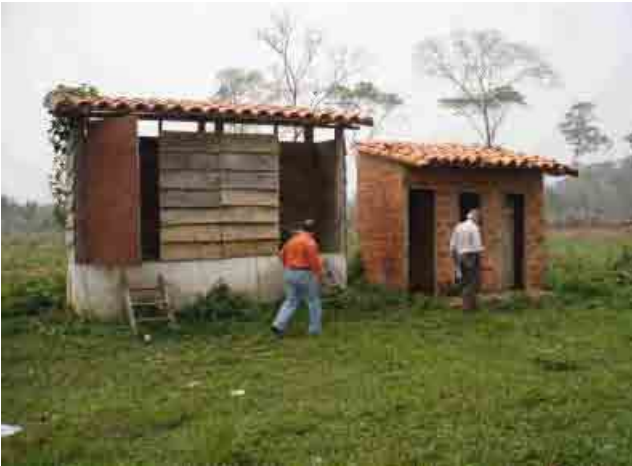
Departamento de Beni 143 Nueva Creacion de Cotoca Instalaciones sanitarias (letrina)
