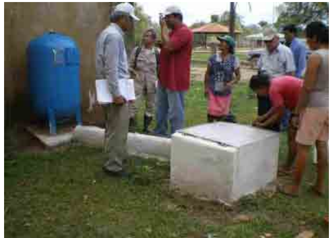
Departamento de Beni 143 Nueva Creacion de Cotoca Equipo impulsor de agua tipo camara de aire
