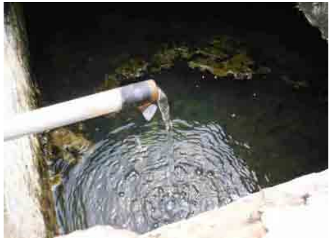
Departamento de Beni 250 Puerto San Borja Interior del tanque elevado hecho de hormigon armado
