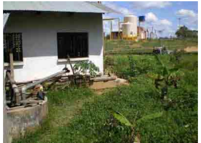
Departamento de Pando 035 Porvenir Pozo redondo y caseta de bomba impulsora
