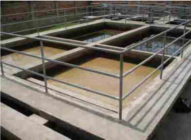
Planta de tratamiento de agua del Municipio de Santa Ana, Departamento de Beni Filtro rapido
