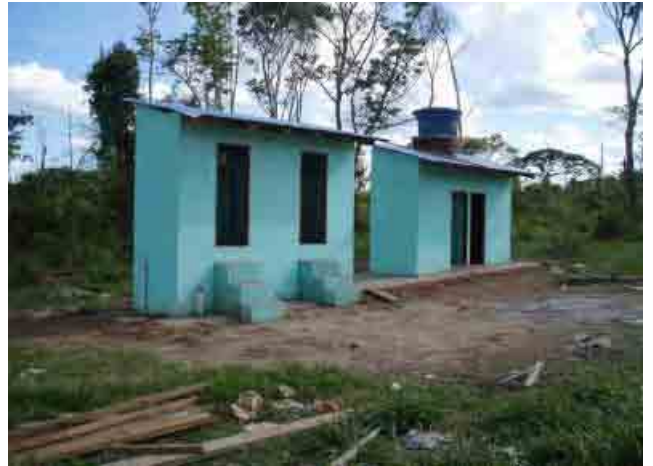
Departamento de Pando 015 Nuevo Belen Instalaciones sanitarias (letrina y ducha)
