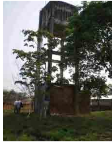
Departamento de Beni_045 Nuevos Horizontes Tanque elevado hecho de hormigon armado
