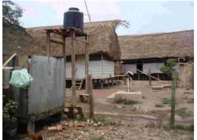
Departamento de Beni 113 Puerto Teresa del Yata Poso, deposito elevado y ducha
