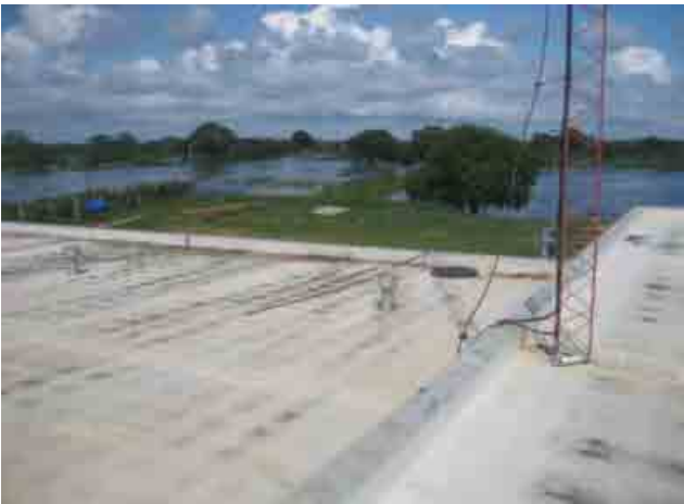
Planta de tratamiento de agua del Municipio de Trinidad, Departamento de Beni Parte inundada por el desborde el rio y el tanque de agua tratada
