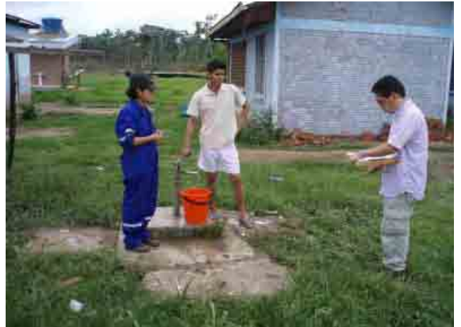
Departamento de Pando 018 Nareuda Pozo equipado de una bomba manual
