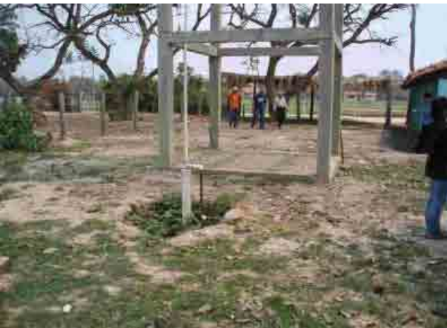
Departamento de Beni 004 San Pablo Nuevo Pozo al lado de un tanque elevado hecho de hormigon armado
