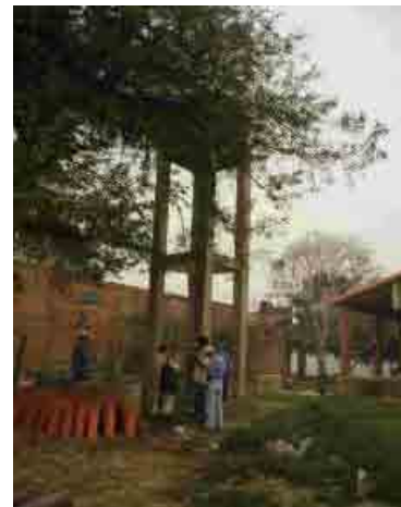
Departamento de Beni 012 Puerto Ballivan Tanque elevado hecho de hormigon armado
