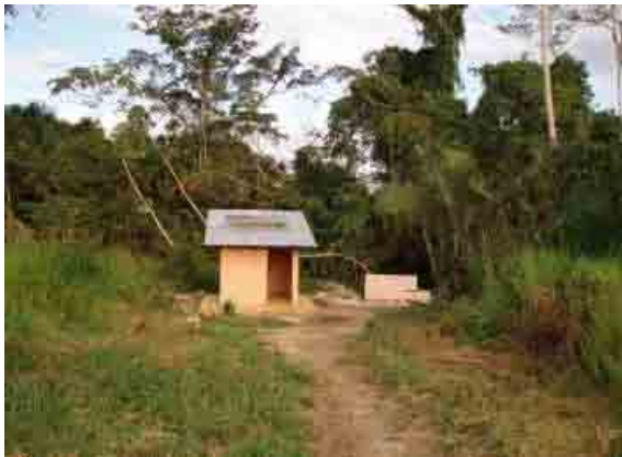
Pando, Proyecto piloto Puerto Nueva Vida Obra de captacion y Tanque elevado (Panel solar)
