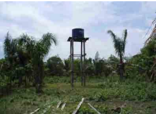
Departamento de Beni 151 Villa San Pedro Deposito elevado
