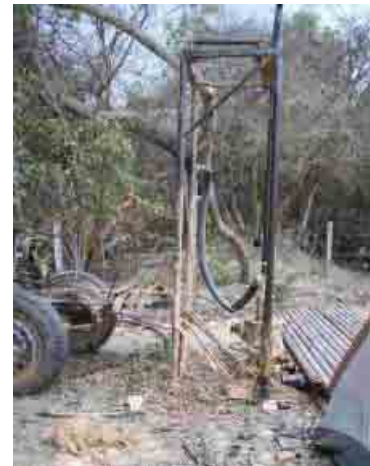
Departamento de Beni 113 Puerto Teresa del Yata Pozo en perforacion
