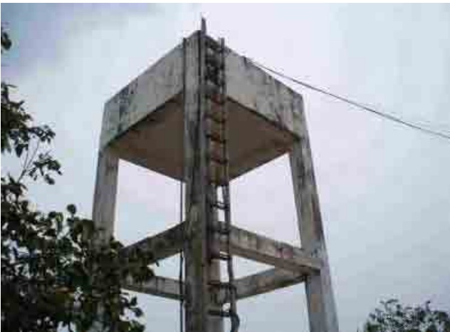
Departamento de Beni 250 Puerto San Borja Tanque elevado hecho de hormigon armado
