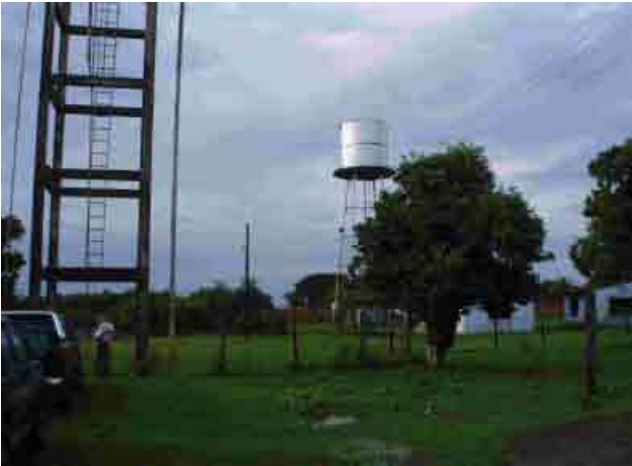
Departamento de Beni 121 Puerto Siles Tanque elevado de hormigon armado (delante) y tanque elevado de acero (detras)
