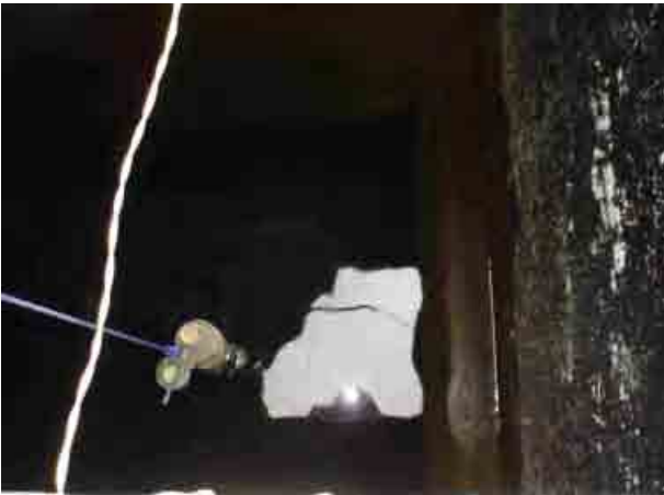
Departamento de Beni 145 Puente San Pablo Interior del tanque
