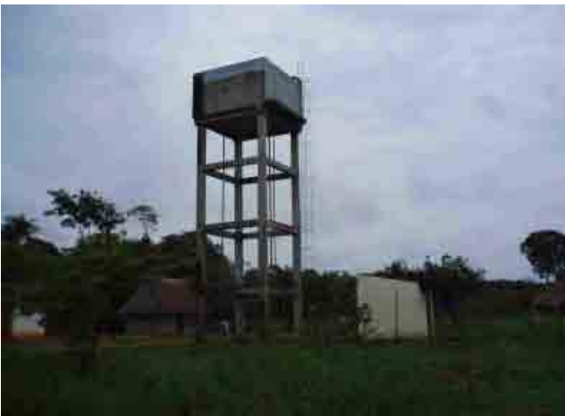
Departamento de Beni 201 12 de octubre Tanque elevado hecho de hormigon armado
