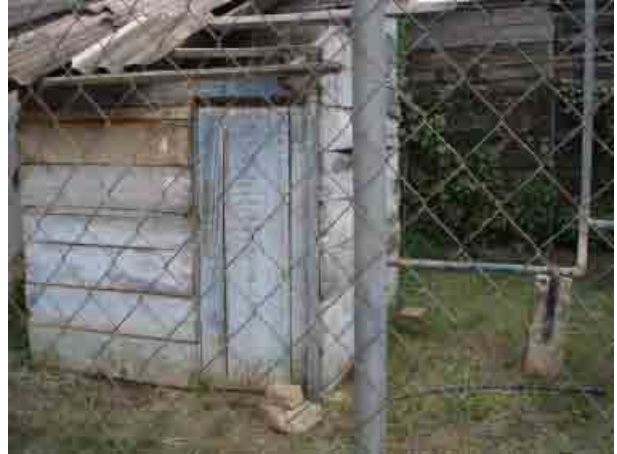
Departamento de Beni 145 Puente San Pablo Caseta de control debajo del tanque elevado
