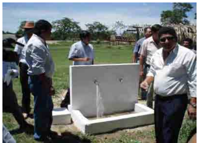
Instalaciones piloto Llaves publicas
