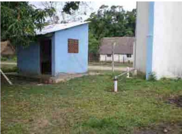
Departamento de Beni 131 Sachojere Pozo y caseta de control
