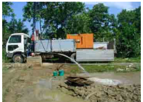
Estudio de perforacion de pozos Prueba de bombeo continuo por 24 horas
