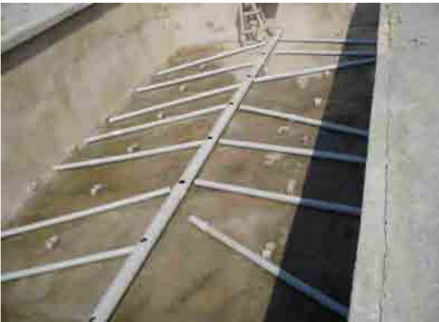
Planta de tratamiento de agua del Municipio de San Ignacio, Departamento de Beni Tubo relector de agua del filtro lento (en construccion)
