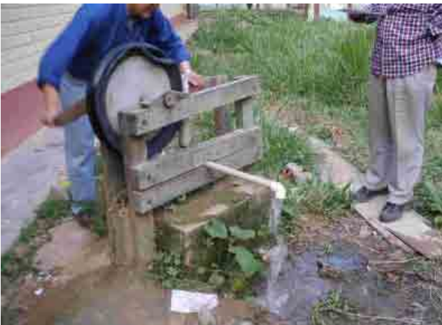
Departamento de Beni 094 Limonsito Pozo equipado de bomba lobular
