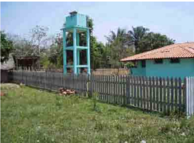
Departamento de Beni 175 Santa Rita Deposito elevado
