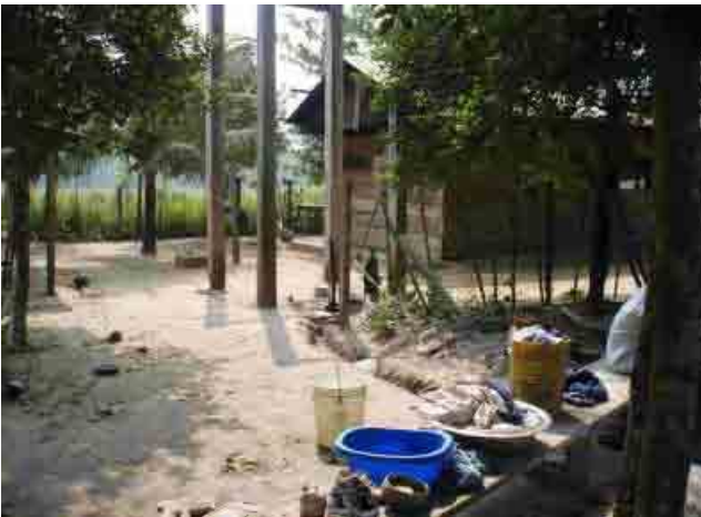
Departamento de Beni 050 Uncallamaya Tanque elevado y llave
