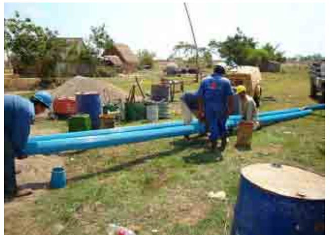
Sondeo Preparando la insercion de tubos de revestimiento
