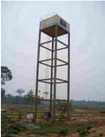
Departamento de Pando 016 Mukuden Tanque elevado hecho de hormigon armado
