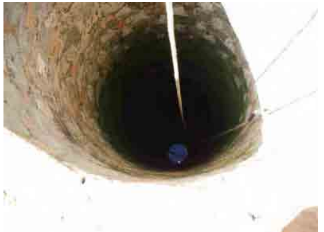
Departamento de Pando 088 Naranjar Interior de un pozo redondo
