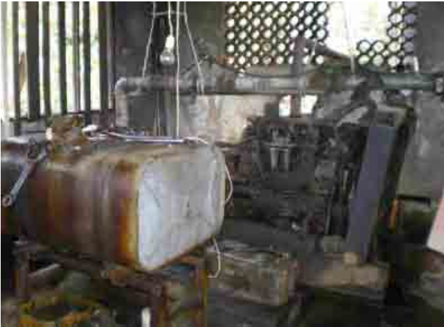
Departamento de Pando 035 Porvenir Generador para la bomba impulsora
