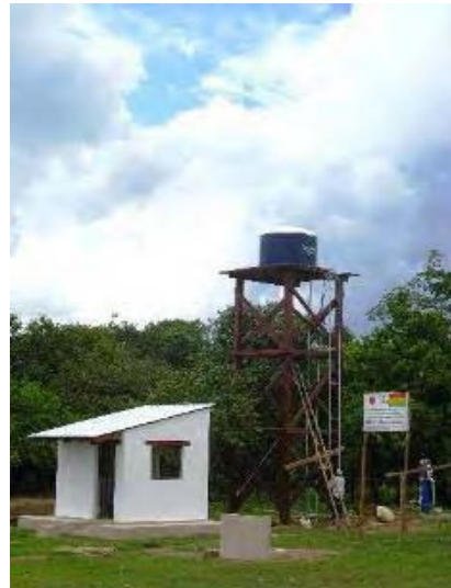
ベニ県 Puerto San Borja 水源地 簡易型高架水槽、管理棟
