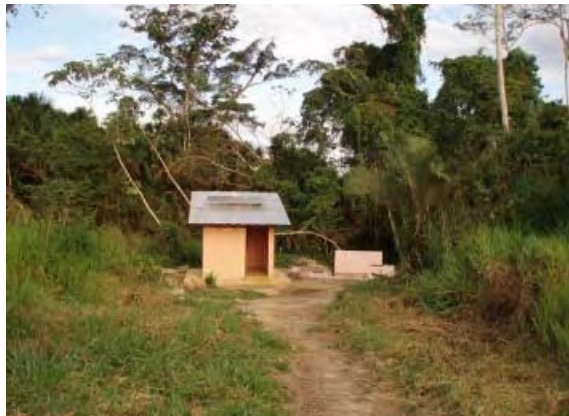
バンド県 パイロットプロジェクト Nueva Vida 湧水取水場、管理棟(ソーラーパネル)
