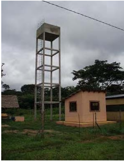
バンド県 パイロットプロジェクト Luz de America 高架水槽、管理棟
