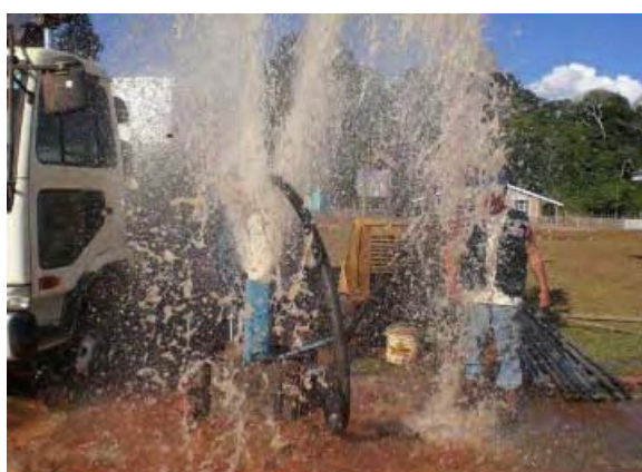
試掘調査 エアークラフトによる井戸洗浄
