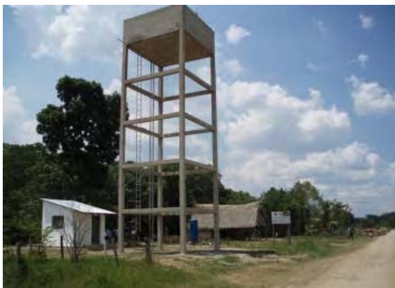
ベニ県パイロットプロジェクト Santa Rosa 水源地 高架水槽及び管理棟
