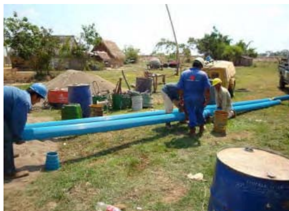
試掘調査 ケーシング挿入準備
