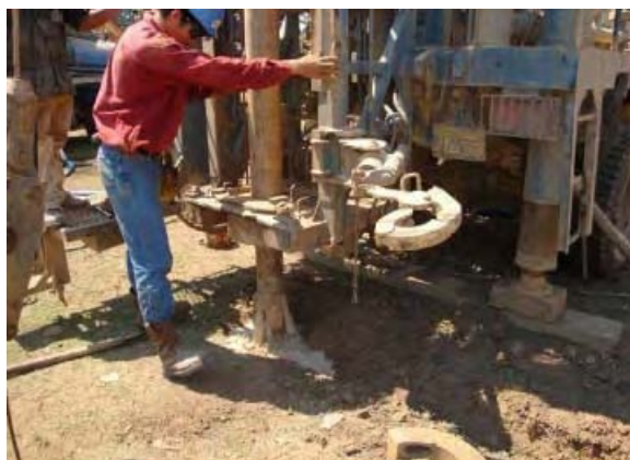
試掘調査 掘削開始
