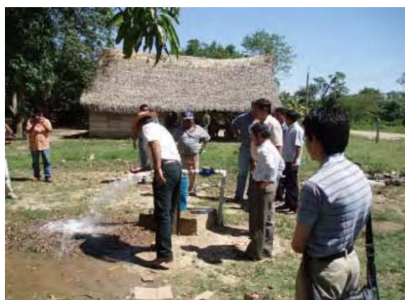
ベニ県パイロットプロジェクト Santa Rosa 水源地 井戸
