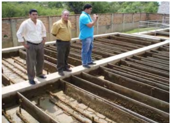
既存給水施設の踏査
