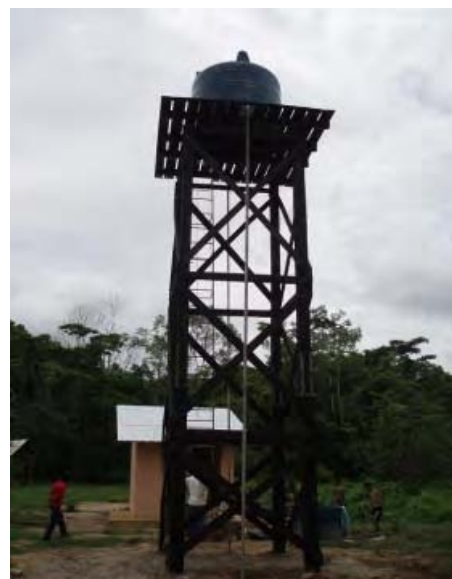
バンド県 パイロットプロジェクト Puerto Copacabana 高架水槽、管理棟
