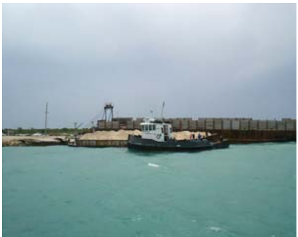
リバー港中央 採石の積み込み作業中
