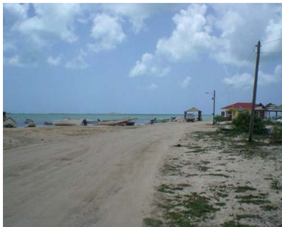
バーブーダ島 観光栈橋へのアクセス道路 右側海浜部は岸壁建設予定
