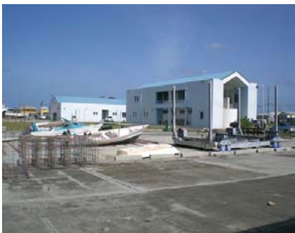
ポイントワーフ水産施設 中央に管理棟、左手 奥は水産加工棟
