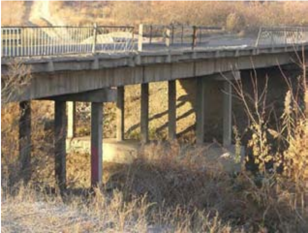
AlmaAta-Bishkek-Tashkent Road。無償資金協力で改修が予定される No. 1 橋梁
