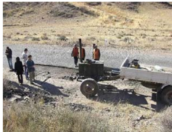
Bishkek-Torugart Road (EM07) Kuvaky pass 付近。日本の無償資金協力によって供与された機材を用いた道路維持管理作業（パッチング）
