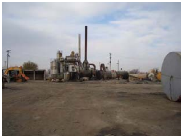
ローカルコントラクター “Mostdorstrol” が保有する Bishkek 郊外のアスファルトプラント
