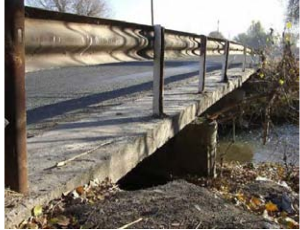
Bishkek-Torugart Road (EM07)。無償資金協力で改修が予定される No. 14 橋梁
