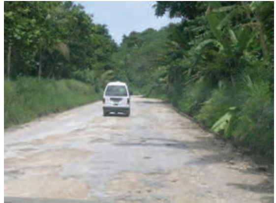
写真 2－1 簡易舗装の痕跡が残る区間
