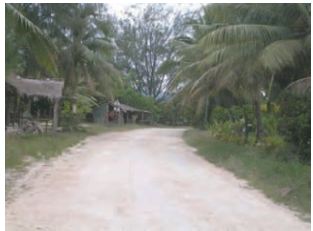
エファテ島リングロード 未整備区間（村落区間）
