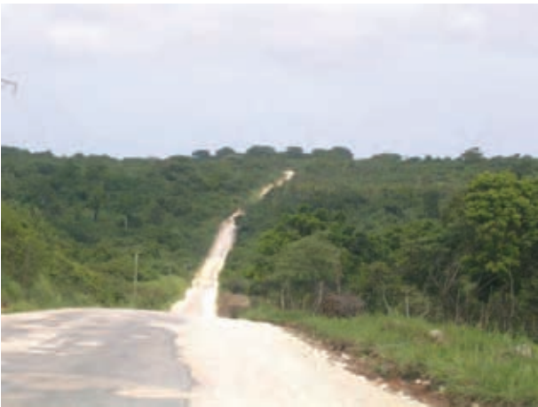
エファテ島リングロード未整備区間
