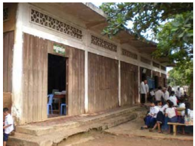
建設地の一部となるため解体予定の既存教員室と図書室
