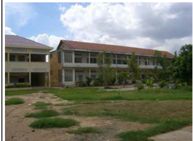
敷地内にある中学校校舎
