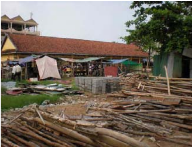
建設予定地：既存校舎を撤去した跡地
