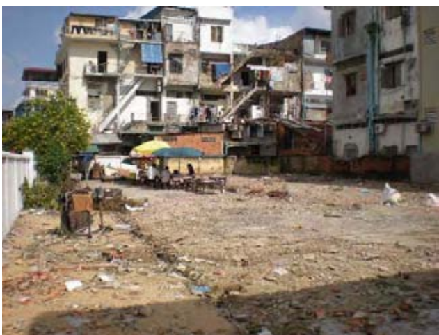
建設予定地：老朽化校舎を解体した跡地
