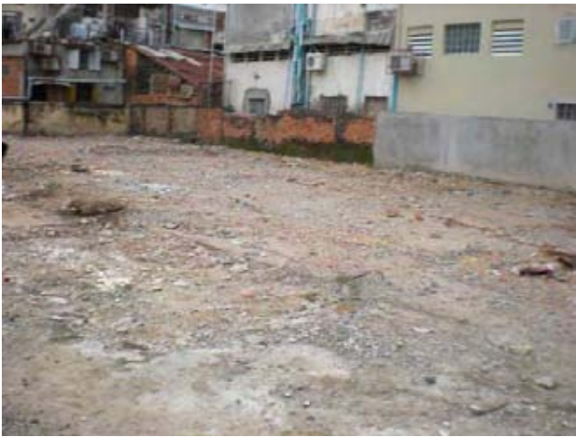
建設予定地：解体校舎の跡地
