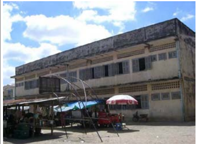
既存校舎に隣接した売店
