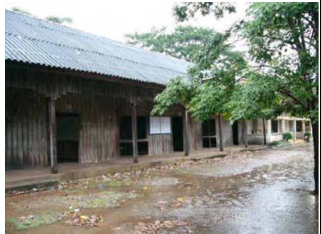
老朽化のため使用されていない既存教室
