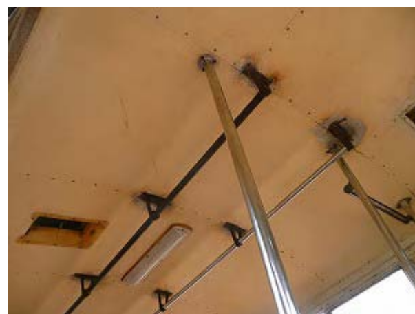
天井板も張り替え済み
