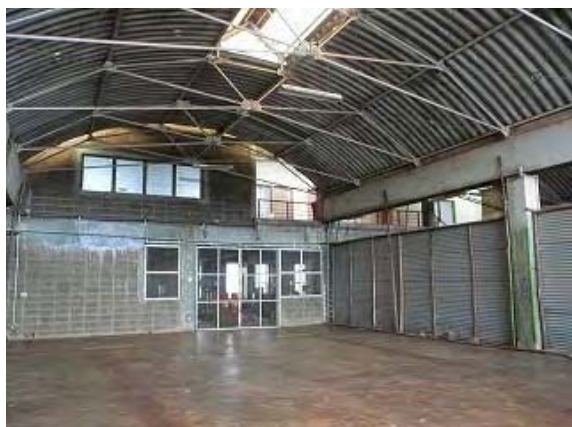
1 .ギテガ車両整備工場内。調査時は使用されていないため、中は空いている状態
