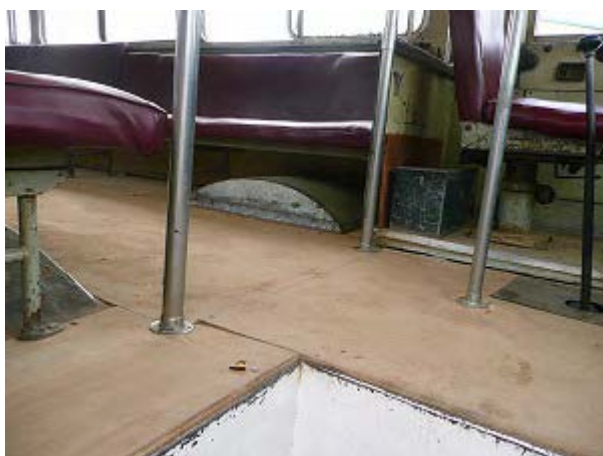
バス床板もOTRACO技術者により張り替え
