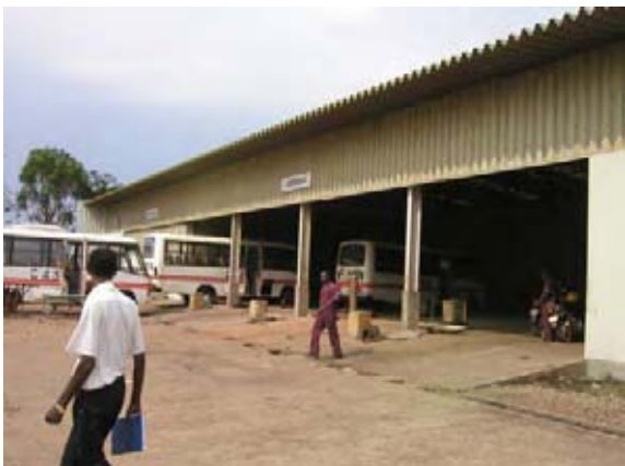
3 . ブジュンブラ車両整備工場(2)。OTRACO の技術部の技師、技士、およびメカニックがバス等の車両の維持管理(点検整備、故障修理等)に努めている。
