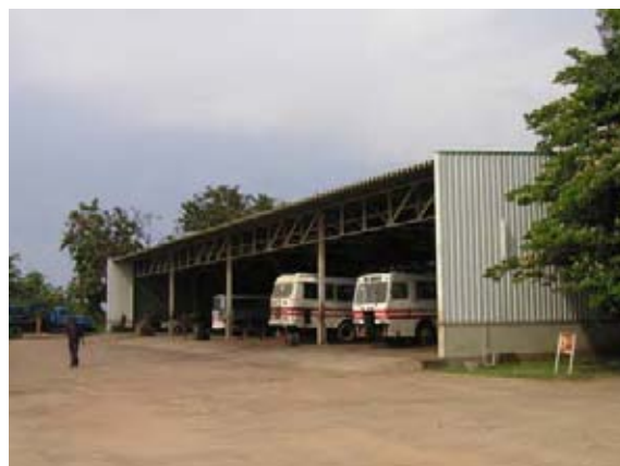
2 . ブジュンブラ車両整備工場(1)。OTRACO が保有するバス等車両の維持管理(点検整備、故障修理等)、および「ブ」国の民間車両に対する車検も実施している。ブジュンブラ本社の敷地に所在
