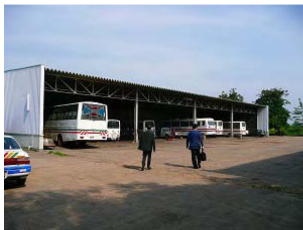
整備が必要な車両は整備場にて保管
