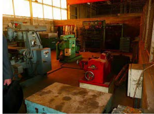
機材も当時設置されたままで活用を継続
