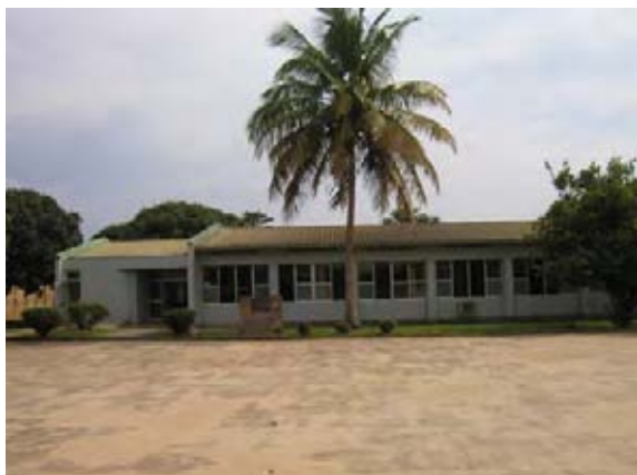
1 . ブジュンブラ本社。「ブ」国の唯一の公共バス輸送機関。わが国の無償資金協力により、ブジュンブラ市内に 1985～1986 年に本社屋、車両整備工場、および車庫が建設された。
