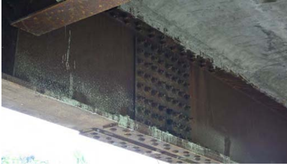
Tayadun II 橋の摩擦接合ボルトによる鋼桁接合部
