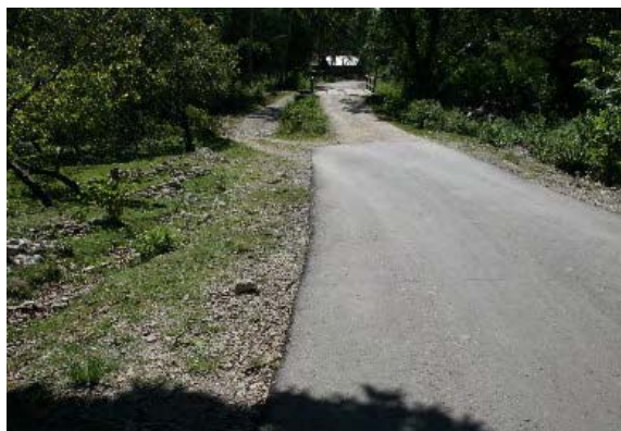
Baubau側からみた橋梁、左の下流側に旧道が見える。Baubau側は地形が上がっている。橋面の高さまで洪水くるそうである。
