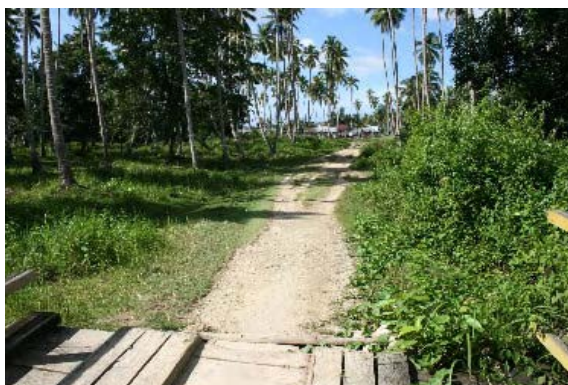
ラブアン側アプローチ
