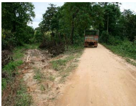
右岸側の取り付け斜路
