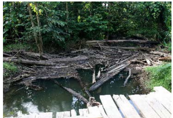
下流側、以前架けられていた木橋の残骸
