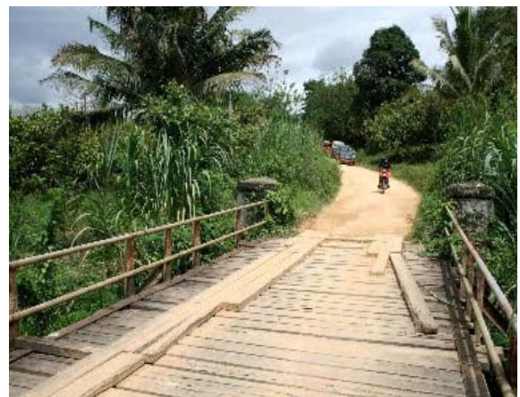
Tinanggea側、左岸側。取り付け道路は山から下ってくる。橋梁は短い11mスパンの橋梁
