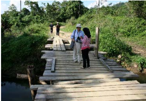
木橋の現橋、少し前に壊れて架け代えたもの。
