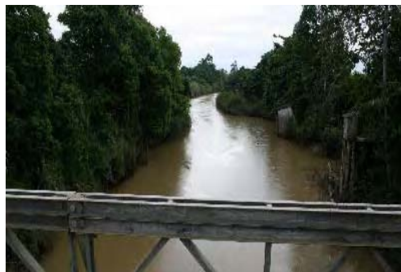
橋梁から上流側をみると、水位観測塔がある。上流側にあるのは傾いた観測塔で放棄されたもの。
