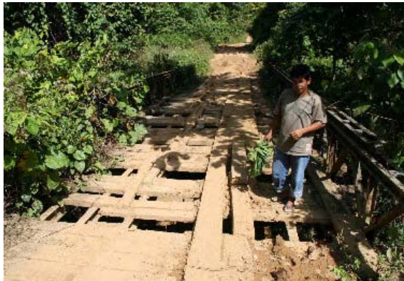
エレケ側から橋をみる。
