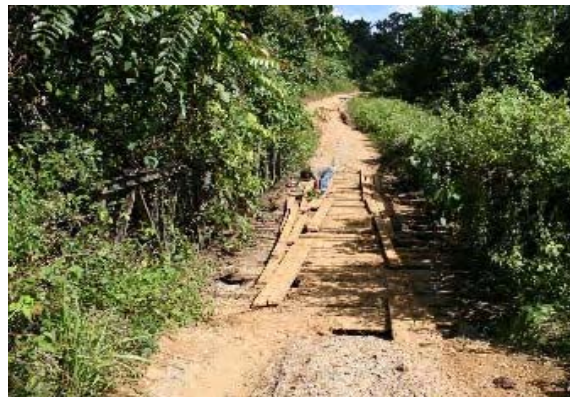
エレケ側からみる橋
