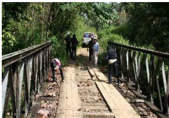
マリガノ側からみる橋。左手奥に大きな木がある。上流側左岸
