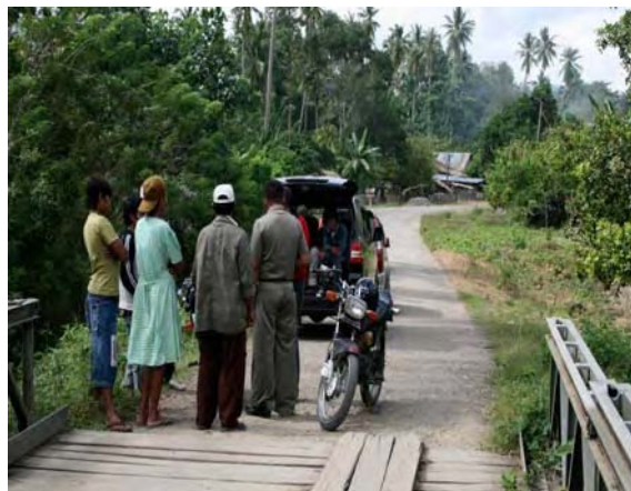
この橋の左側に旧道路がある。この地点から村までは約80m。右側には空き家がある。
