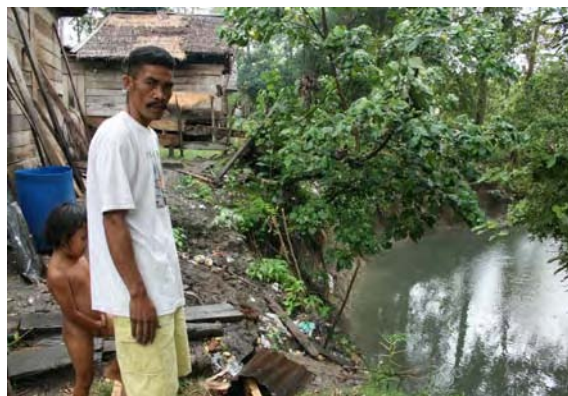
住宅近くまで洗掘が迫っている。
