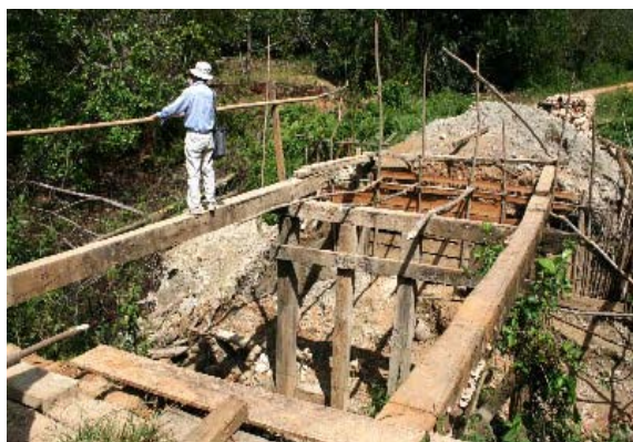
木橋が壊れたので木橋を再建設しようとしていた。工事費は北ブトン県の工事費らしい。
