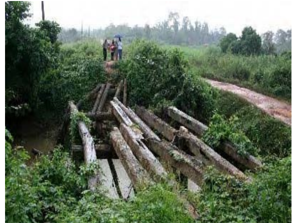
左岸側からみる右岸側。その向こうは田である。
