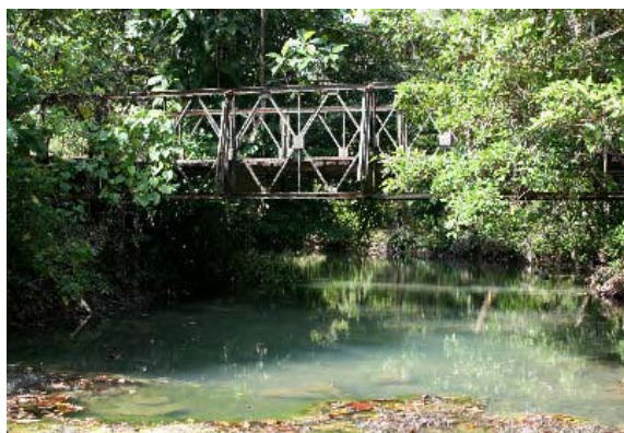
下流側の旧道から現橋をみる。
