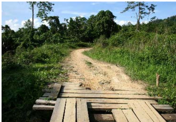
エレケ方面。橋は盛土で狭くした位置に架けられている。
