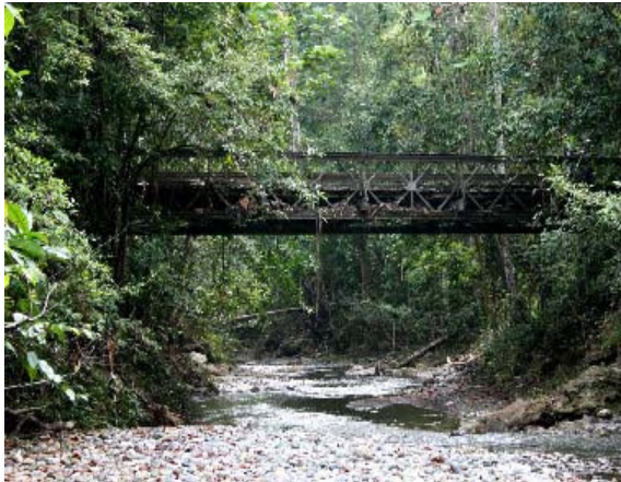
上流側からみる。右がエレケ側、左がマリガノ側
