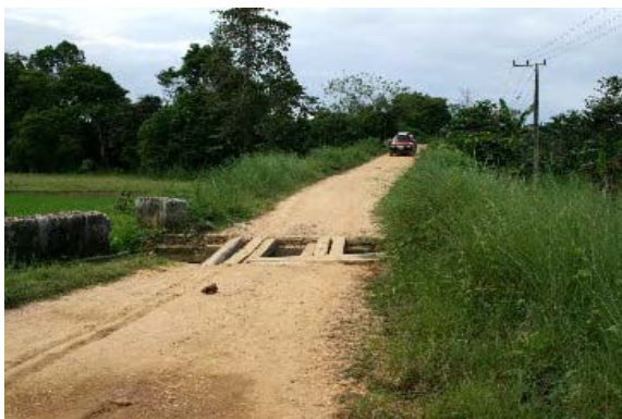
右岸側のアプローチ道路。こちらは平地になっており、盛土の斜路がアプローチになっている。
