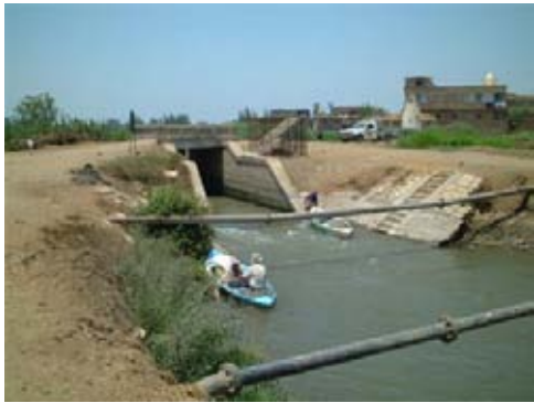
取水口（デリバリーチャンネル）の外観
