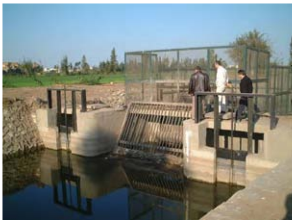
デリバリー水路 水位調整施設
