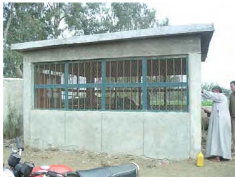
メスカへ送水するポンプ場
