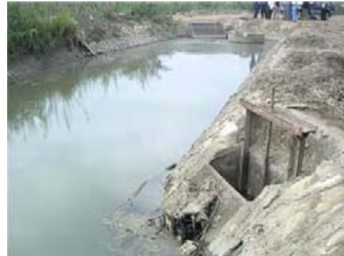
バハールヌール水路からメスカへ送水 するポンプ場への取水口
