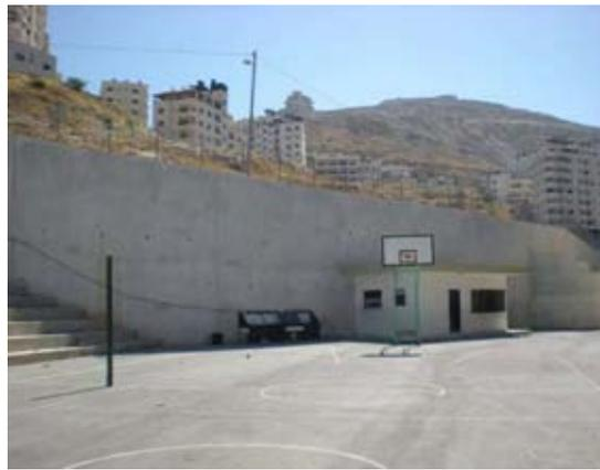
イスラム開発銀行の援助により建設された学校。斜面を切り土し、コンクリート擁壁により土留めを行っている。
