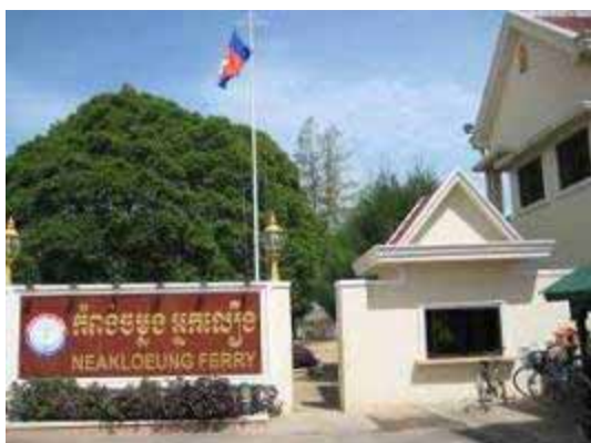
写真-4.1.1 ネアックルン・フェリー事務所
