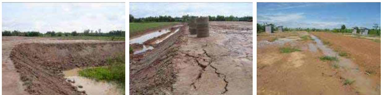
移転地の造成作業（盛土）
