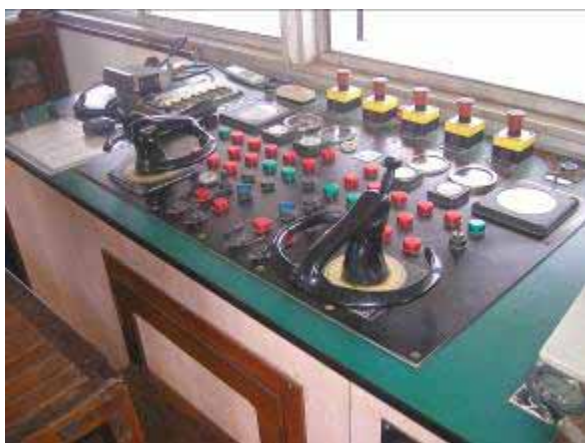
写真-4.3.5 操舵室内の操舵スタンド 操舵スタンドの計器盤はボタン、インジケーター共破損や異常はない。手前左右に黒いハンドル様の物が見えるがこれはショットル・ラダープロペラの操縦桿であるが4.3.3項で述べたように扱いには経験を要す。
