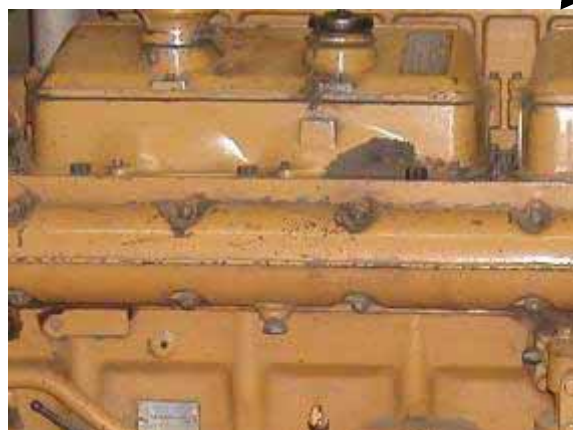
写真-4.3.7 シリンダーヘッドカバーの接合部
