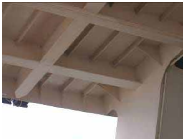
写真-4.3.2 操舵室床の裏側 車輻甲板から6.4mの高さにあり、暴露部であるにもかかわらず錆びはない。拡大してよく見るとタッチアップらしき塗装の跡があり、手入れをしていることが判る。
