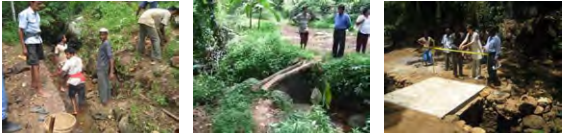
図IV-20 建設作業（左）／改善前の横断橋（中央）／改善後の横断橋（右）
