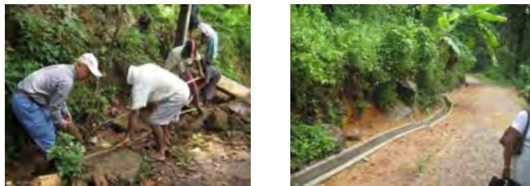
図IV-19 工事前の排水路の清掃（左）／改善された排水路
