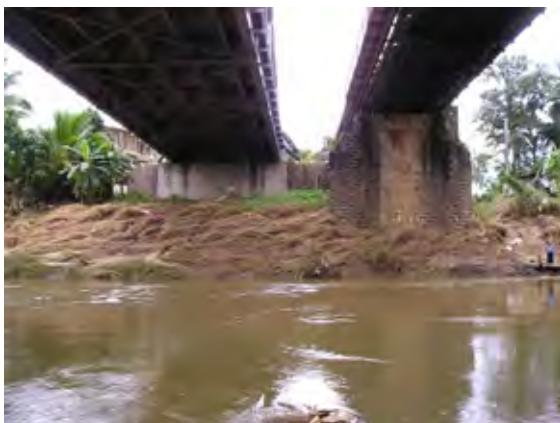
ラトナブラ市内スチールトラス橋 (水位観測所が稼働中)
