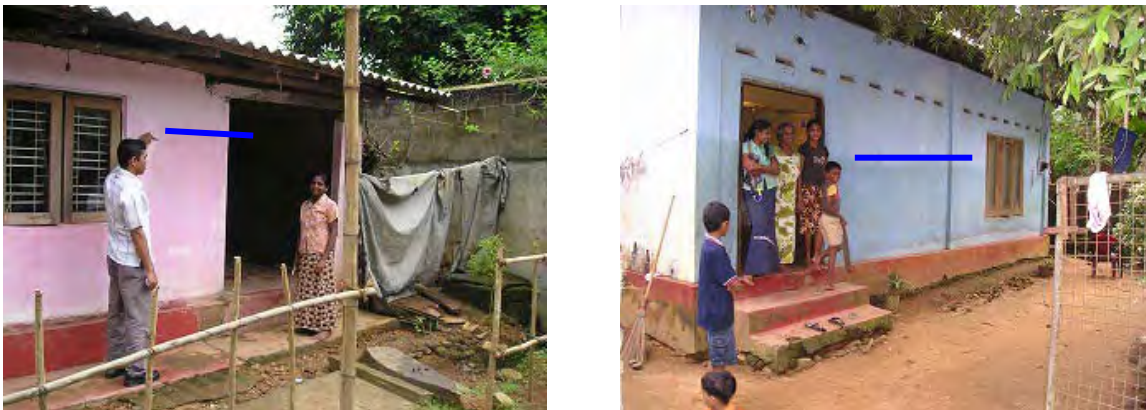
ラトナプラ市内の一般住居に残る洪水痕跡（2008 年 5 月 6 日撮影）
