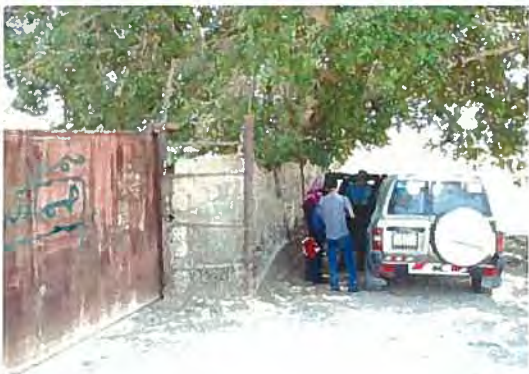
No. 34 : 壁・フェンスの撤去が必要となる。 (幅 1m、延長 100m 程度)
