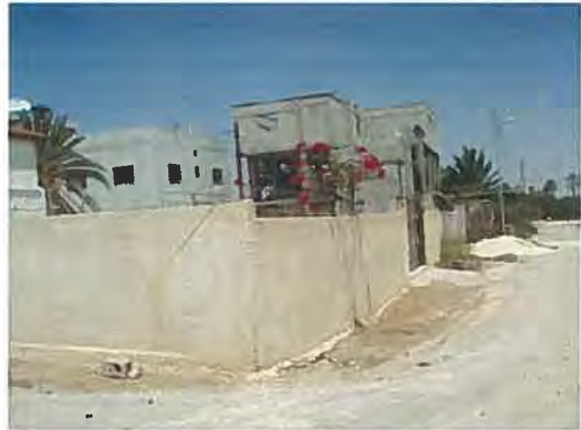
No. 22 : 壁の撤去が必要 (壁を幅 3m、延長 20m 程度撤去)
