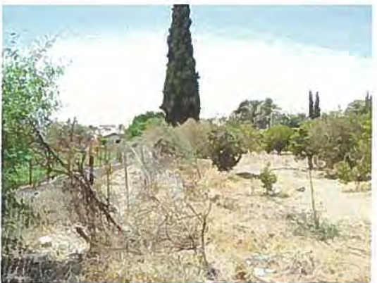
No. 58 : 道路整備予定区間の高木、果樹、 フェンスの撤去が必要 (150m)
