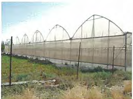
No. 73 : ビニールハウスを 9m 幅で全面撤去 する必要がある。(9m×80m)
