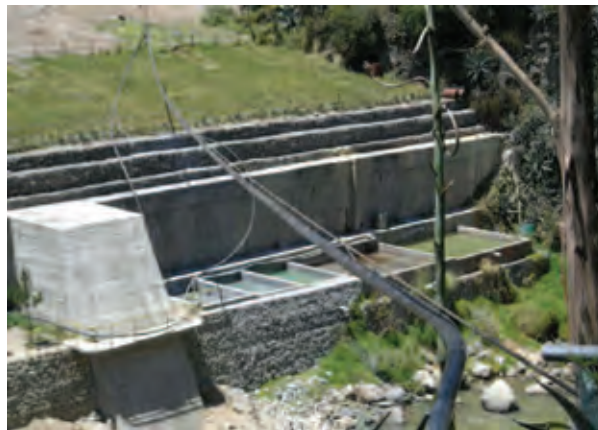
図－8 Minera Huinac 社の旧廃さい堆積場（覆土、植栽、浸透水処理など閉山対策を実施済み）
