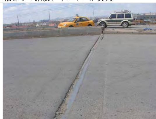
北側伸縮継ぎ手部 継ぎ手を残して舗装をオーバーレイ
