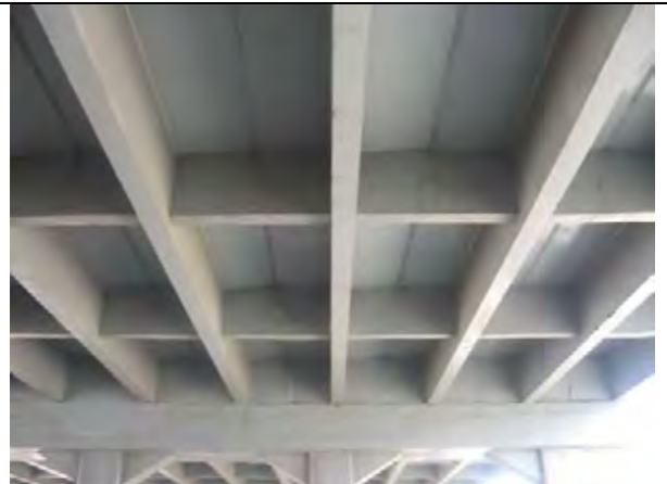
プレキャストT桁、横桁は表面を補修した箇所があり現場打ちと推定される。：荷重制限されており、目立った損傷は無い
