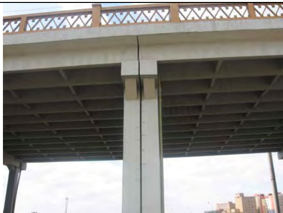
単純桁であるが、床版部を連結している。
