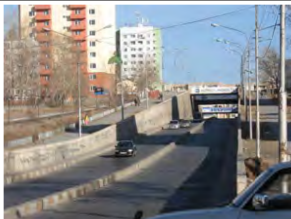
ウランバートル市内のサンサールトンネル；縦断勾配6.5%。寒気には凍結による事故や、通行が制限されるなどのトラブルが多い。
