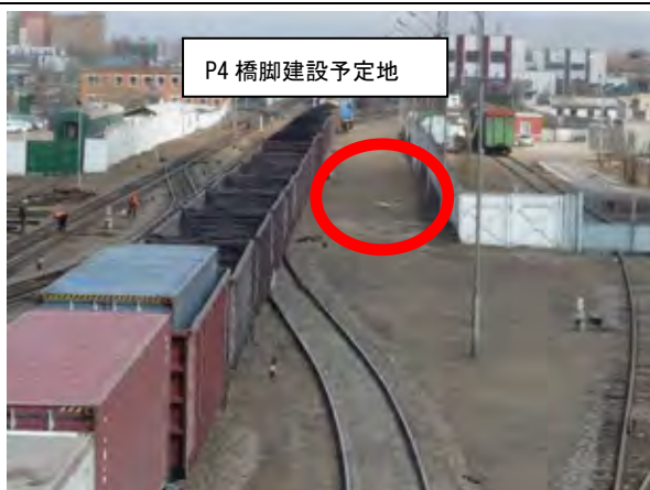
P4 橋脚建設予定地；P4 橋脚建設予定地。スペースが狭く、鉄道との近接施工となる。P4 橋脚から写真左側に向かって送出し工法により上部工の架設が行われる。
