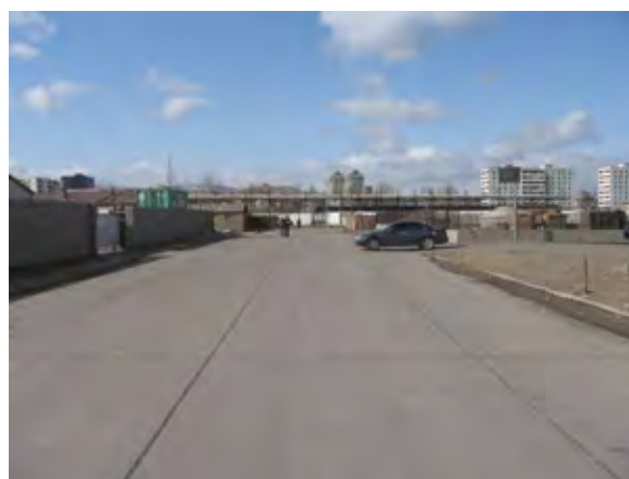
南側アプローチ部分（北向き）；写真正面は大統領専用プラットフォーム。現況はコンクリート舗装。道路両脇は、本事業に伴い用地取得が必要。
