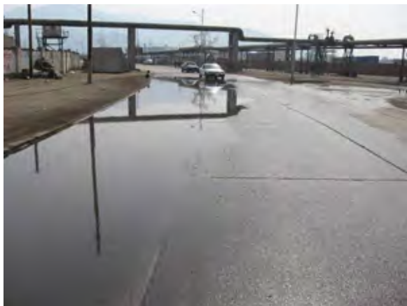
立体交差終点部分（エンゲルス通り南向き）；幅員が狭いため、本事業に伴いモンゴル側負担による4車線拡幅が必要となる。写真右側は大型トレーラーが出入りするコンテナヤード。
