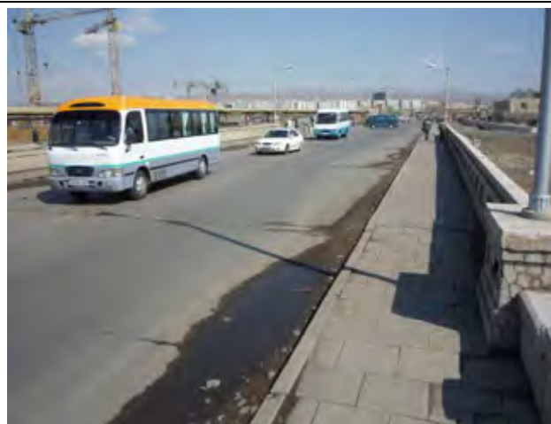
エンゲルス通りトーラ川にかかるドゥンドゥゴル・ドゥンドゥ橋；損傷が激しく、将来計画に対する幅員も十分でない。エンゲルス通りの拡幅に伴い、再建設が必要。
