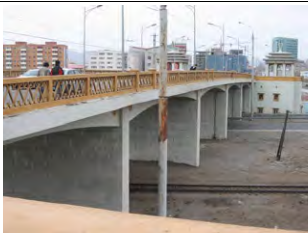
平和橋：1961年に中国により建設された鉄道を跨ぐ2つの道路橋のうちの1つ。荷重制限を行っており、路線バス以外の大型車両は通過していない。
