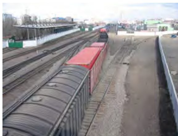
鉄道交差点部；1 日 30 本以上の列車が通過する。将来的には電化を予定。左手は大統領専用プラットフォームで、高架橋の建設に伴い、一部屋根を撤去する必要がある。
