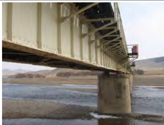
トーラ川にかかる鉄道の鋼製橋梁；1967年に旧ソ連で製作された。状態は比較的良好で、鉄道局により定期的なメンテナンスも実施されているため、十分な能力があると考えられる。
