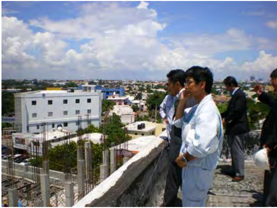
新センター建設現場
