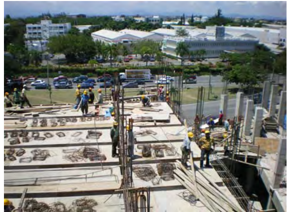
新センター建設現場
