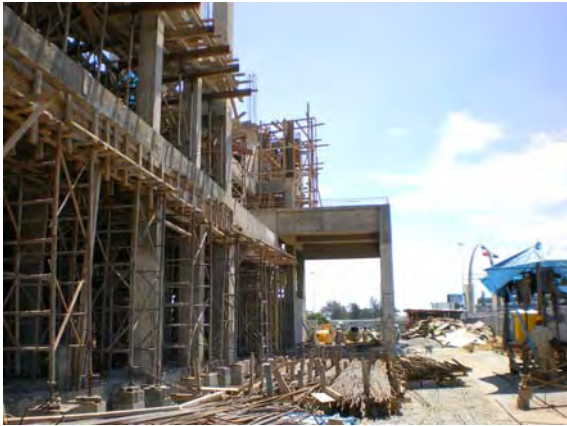
新センター建設現場
