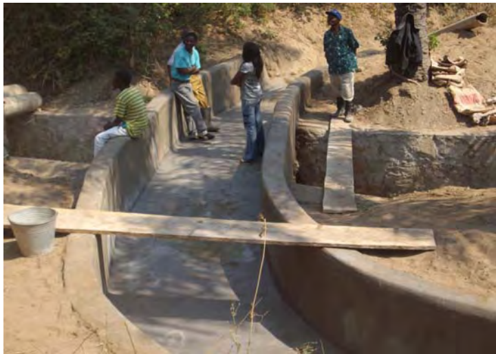
Actividade piloto: Parte reabilitada de irrigação (Comuna de Canjala)
