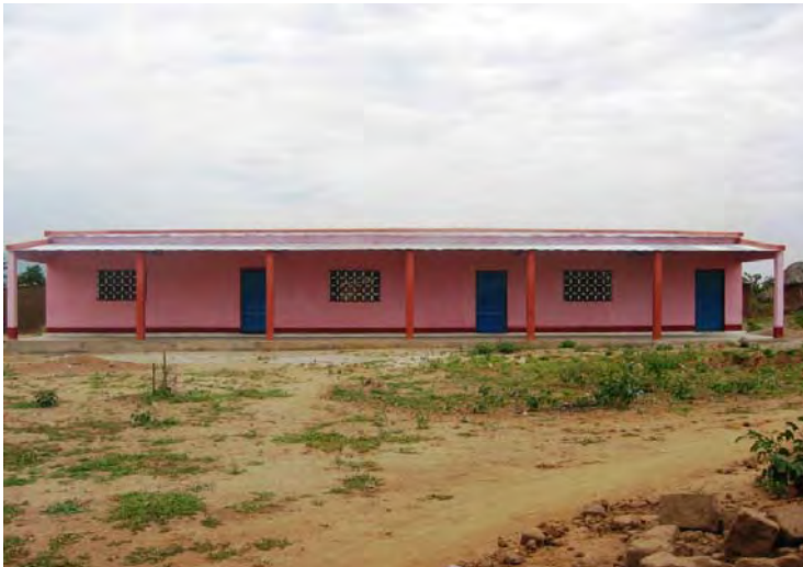
Actividade piloto: Edifício de escola construída (Comuna de Canjala, Aldeia de Kateque)
