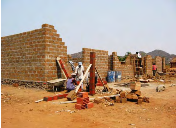
Actividade piloto: Construção de escola (Comuna de Canjala, Aldeia de Kateque)
