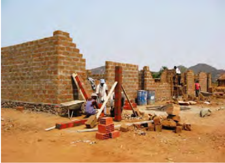
パイロット事業: 小学校建設 (カンジャラ村、カテケ集落)
