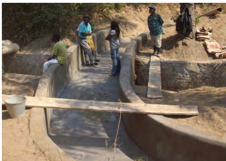
パイロット事業: 用水路の修復部分 (カンジャラ村)
