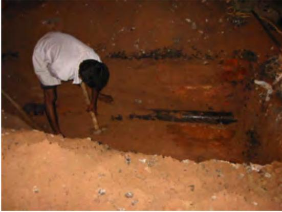
小口径鋳鉄管（φ100mm）の管内スケール除去作業のために管を掘り出しているところ。
