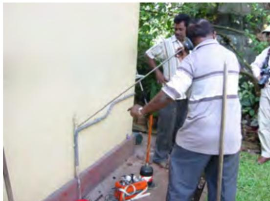
音聴棒を使って家庭敷地内の漏水探査をしているところ（有料で実施）。
