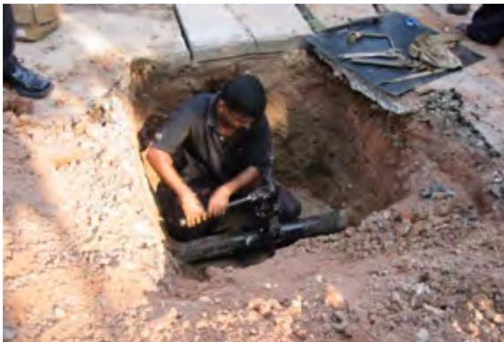
配水管に穿孔機で給水接続管用の孔をあけているところ。
