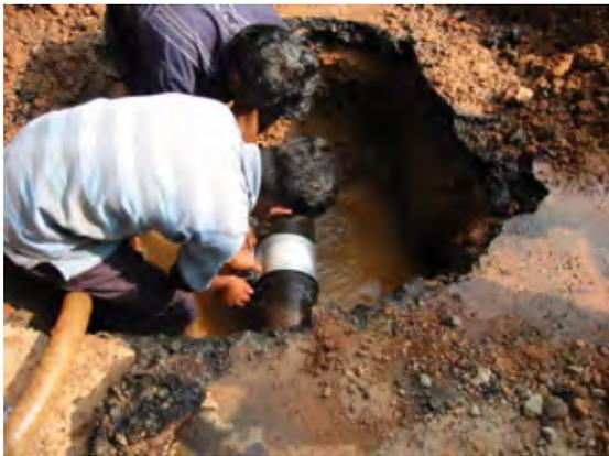
鑄鉄管に管補修用クランプを取り付け止水したところ。
