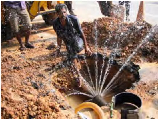
道路下の老朽化した鑄鉄管に亀裂が入り漏水しているところ。
