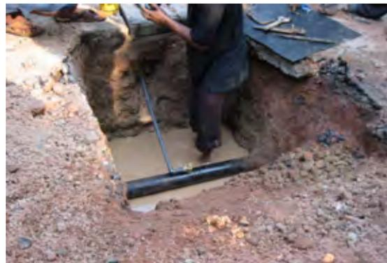
配水管に取り付けられた給水接続管。配水管壁のねじ孔だけの接続でサドルを使用しないため僅かの衝撃でも漏水の可能性はある。
