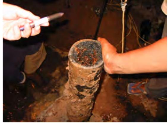
管内スケール除去用のスクレーパー（回転ブラシ）を挿入するために切除された管の断面。
