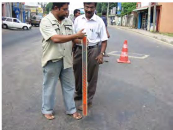
金属探知器で道路内に埋設したバルブボックスを探知しているところ。
