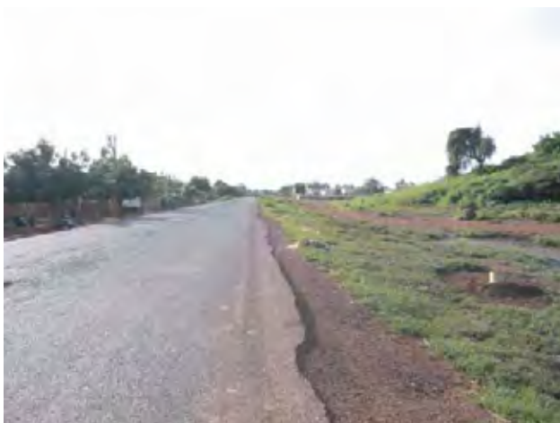
⑤ 前面道路中央より北西側を望む
