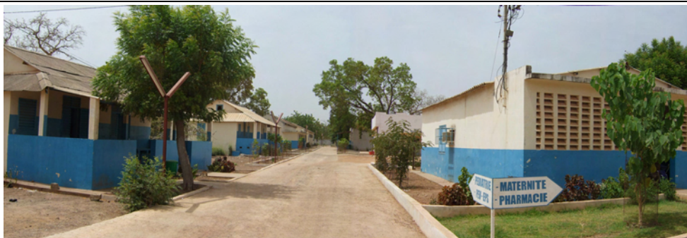
タンバクンダ保健区の保健センター。ケドゥグ保健センターと同様な分棟式の施設配置を採用している。
