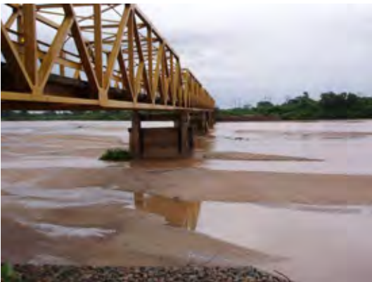
11. 日本の無償で改修を行った国道4号線の日本・ポリビア友好橋（旧称：アイゼンハワー橋）
