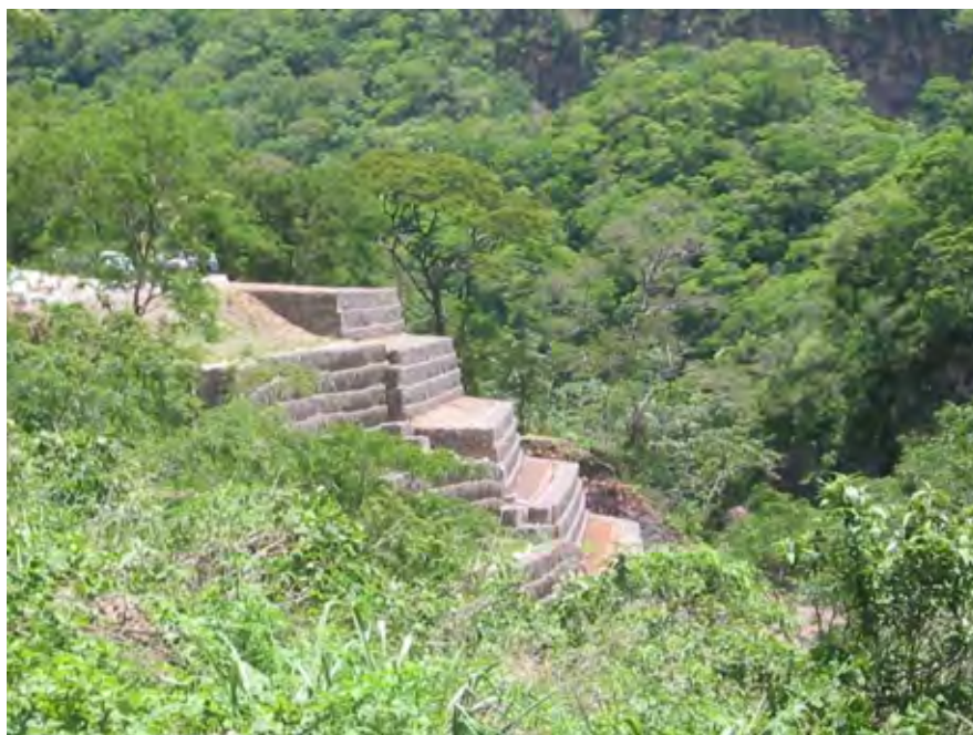
写真4-1 ふとんかごの多段積みにより斜面对策した事例
