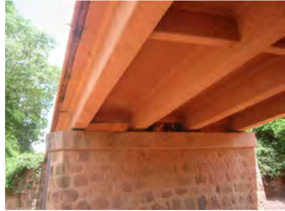
写真 2 - 3 国道 7 号線上の橋梁 (桁が流水に浸かった形跡が残る)
