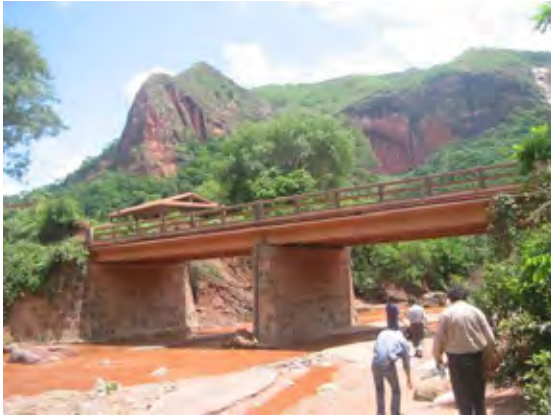
写真 2 - 3 国道 7 号線上の橋梁 (桁が流水に浸かった形跡が残る)
