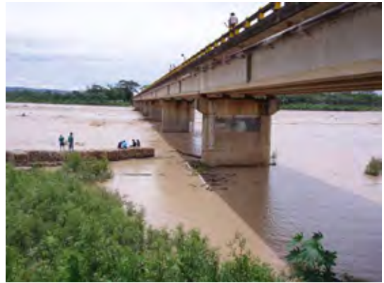
10. 橋脚の沈下を防ぐためにケーソン基礎による補強を行った国道4号のヤパカニ橋
