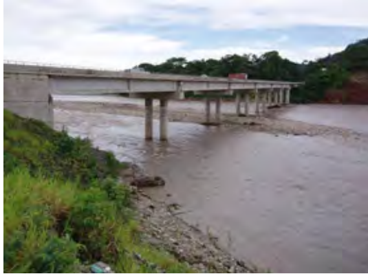
13. 洪水で押し流され、CAFの資金で再建された国道4号のウムシオ橋
