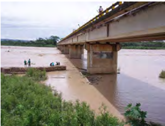
写真 2 - 4 国道 4 号線ヤパカニ橋 (小口径ケーソンにて基礎を補強)
