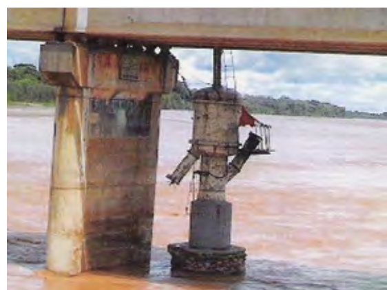
写真 2 - 4 国道 4 号線ヤパカニ橋 (小口径ケーソンにて基礎を補強)
