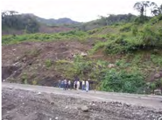
15. 国道4号のエルシジャールの地滑り、現在、排水溝工事中
