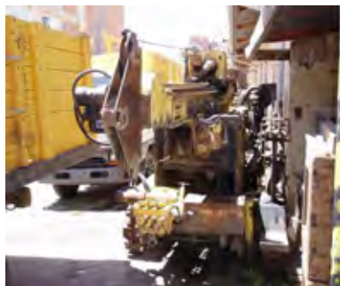
水平孔掘削のための水平ボーリング機械
