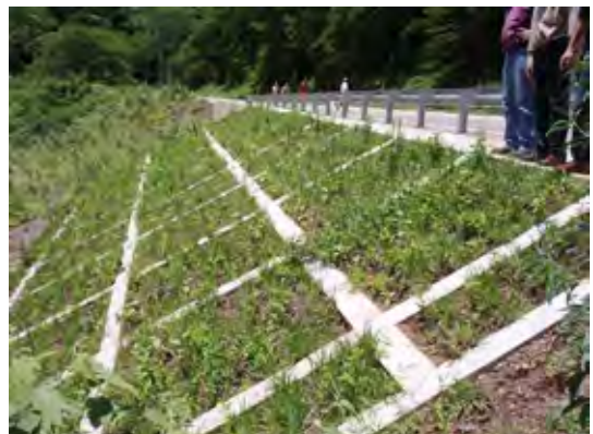
6. 平成 19 年の開発調査で実施した国道 7 号線のパイロット工事
