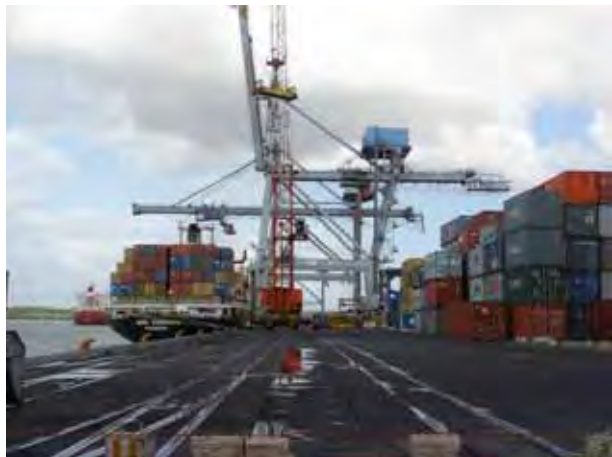
ガントリークレーン(SSG, 全3基) ・エプロン直背後にまでコンテナが迫っている
