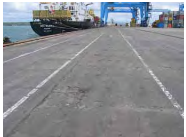
コンテナバース ・部分的にエプロンに損耗が見られる
