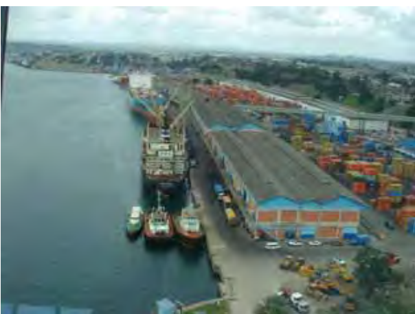
一般貨物バース(コントロールタワーより) ・岸壁直背後に上屋があり、その背後はコンテナ置場 に使用されている
