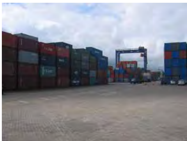
コンテナターミナル ・実入りコンテナが4~6段積みされている
