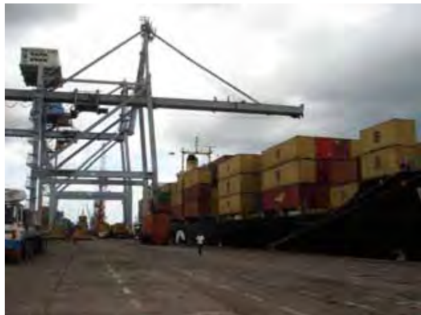
ガントリークレーン(SSG, 全3基) ・35.6t 吊
