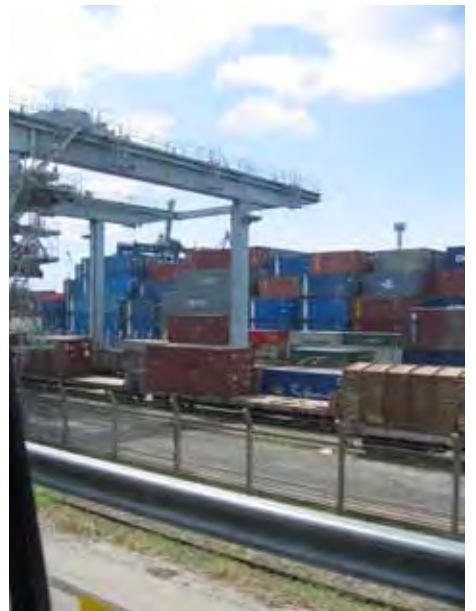
貨車にコンテナを積込・荷卸する ガントリークレーン(1基のみ)
