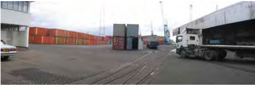
一般貨物ターミナル 鉄道の引込線とトレーラーの通路が交差している
