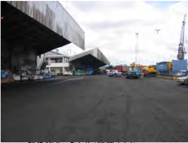
一般貨物ターミナル(貯蔵上屋) インターロッキングブロックで舗装されている
