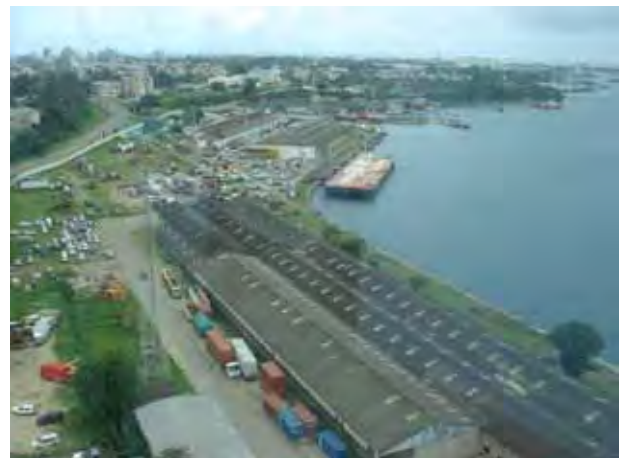
ドックヤード方向(コントロールタワーより)
