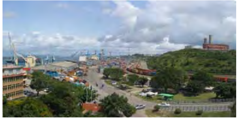
コンテナターミナル(KPA 庁舎より) コンテナヤード 背後には鉄道の引込線と高低差 50m を超える丘が 迫っており、背後へのヤード用地拡張は難しい
