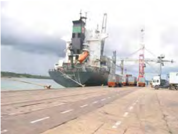
コンテナバース(荷卸し作業中) ・エプロンに損耗が見られる
