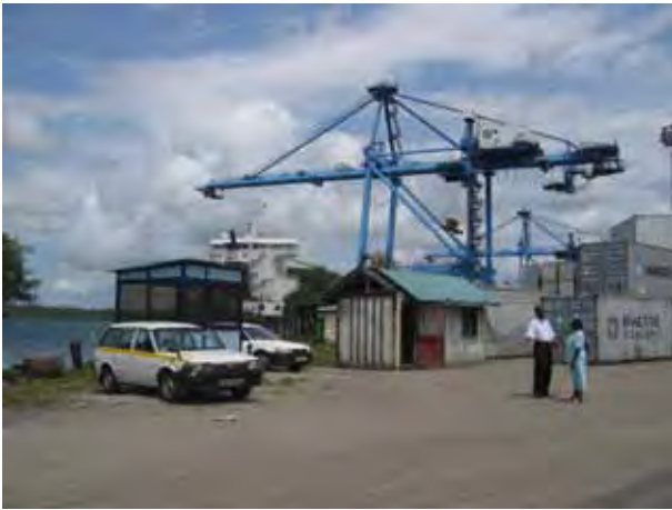
コンテナターミナル方向
