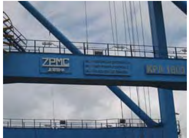
ガントリークレーン
