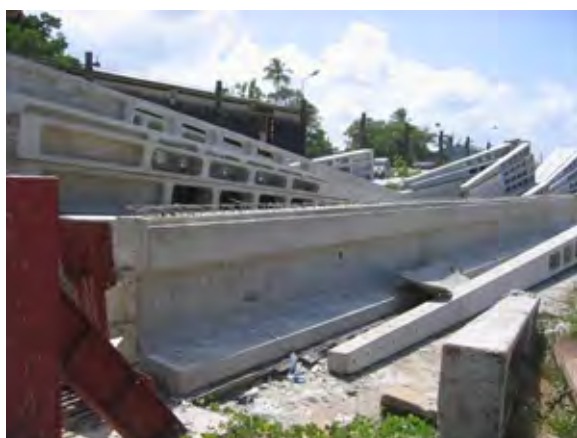
写真5-1 プレキャストコンクリート工場全景
