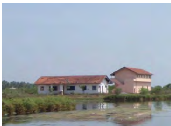
写真3-11 右が漁港の多目的ホール 1階は漁具の整備場、上階は休憩所や機材置き場
