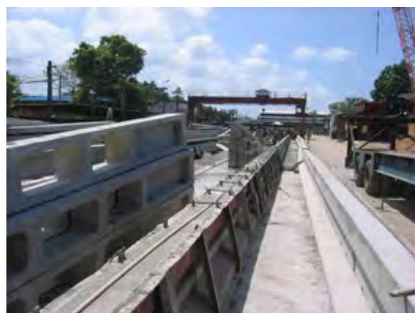
写真5-2 桁長25mPC桁の製作
