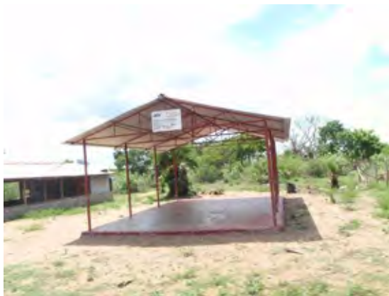
写真 3-9 3.5m×8m の集会施設 日本の NGO、JEN によって提供されたパニ チャンケニ村の集会所。同様の施設なら約 30 万円で建設可能
