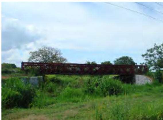
Bridge No. 3（247／2橋）全体 （北側から撮影）
