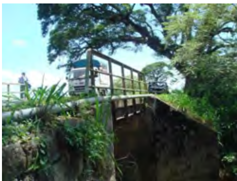
Bridge No. 2 (241/2 橋) の側面 (東側から撮影)
