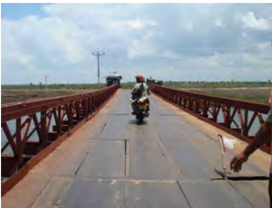
国道 15 号線の仮設道路橋（AFD 支援によ って架け替え工事が予定されている）
