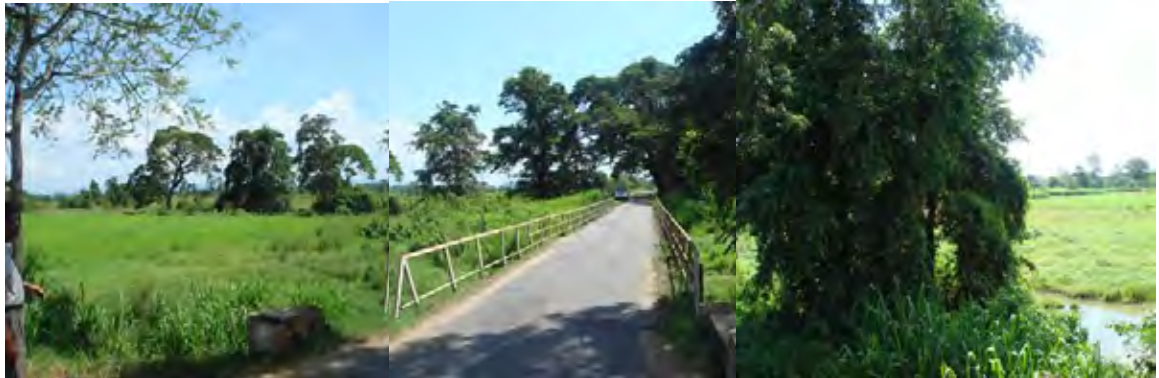
Bridge No. 2（241／4橋）の周辺の様況。両側に耕作地が広がっている。（東側から撮影）
