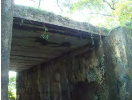
Bridge No. 2（241／3橋）の桁下
