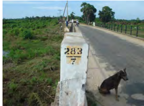
Bridge No. 3（283／7橋）の表示線の様子（西側から撮影）
