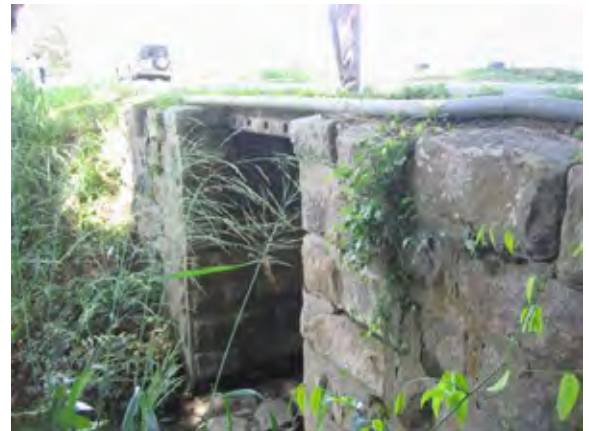
写真2-6 241/3橋 橋梁側面の状況
