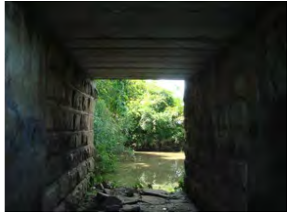
Bridge No. 2（241／3橋）の奥（北側）に見える池は乾季になると発生する。
