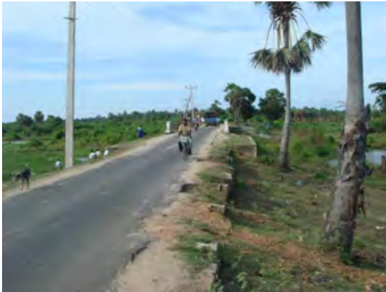
Bridge No. 4（283／7橋）と前後の国道5号線の様子（西側から撮影）
