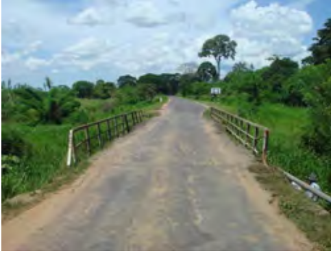
Bridge No. 1 (240/4 橋) 付近の状況
