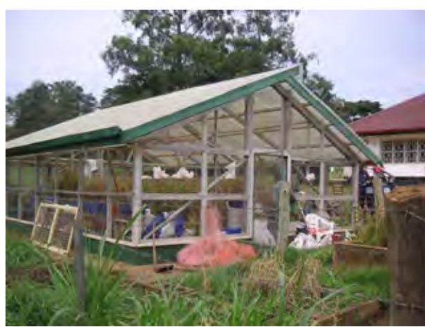
既存スクリーンハウス全景
