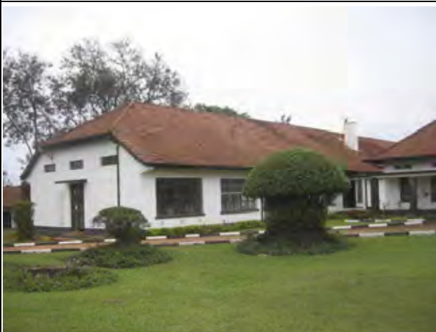
中央研究・管理事務棟左翼の研究室棟 外壁は塗装され、独自に整備されている。
