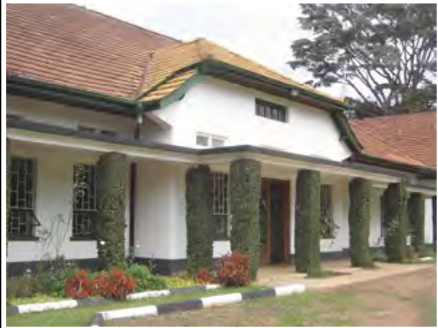
中央研究・管理事務棟正面部の近接写真
