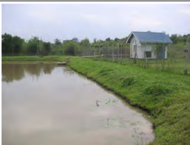
既存ポンプ場上屋及びため池（ネリカ試験圃場 A）
