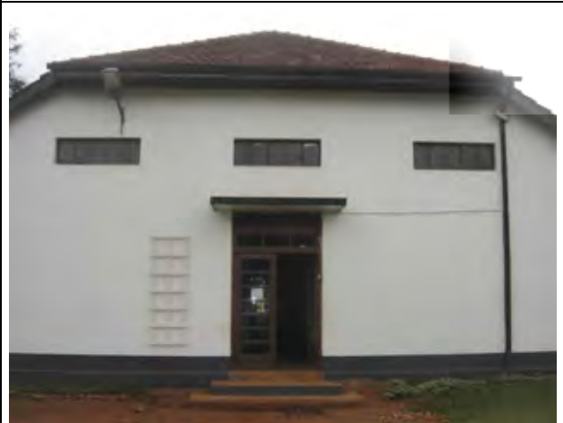
中央研究・管理事務棟右翼の研究室棟の入口部 屋根裏部の採光口が設けられている。
