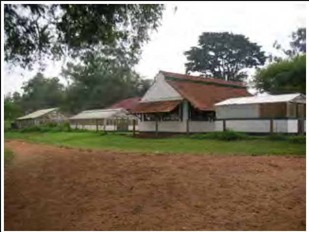
本部・研究ゾーン南側の農業研究施設 写真左から、稲スクリーンハウス、キャッサバ実験棟からなる。施設は老朽化が進んでいるが、塗装など施設の維持管理状況は良い。
