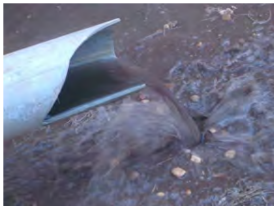
井戸洗浄排水
