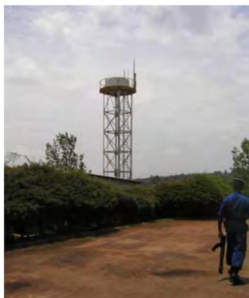
5. 高架水槽。ギテガ支社の給水のための高架水槽。重力給水方式。水道水が敷地内に引き込まれており、井戸水と併用している。
