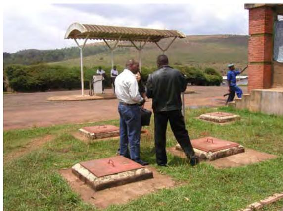
6. 給油設備。写真手前はバス等車両の燃料の地下埋設タンク。写真奥は給油スタンドである。
