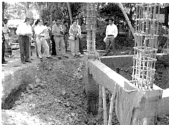
建設中のパイプ給水施設（ジコルガチャ郡砒素対策計画）
