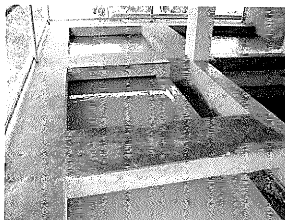
給水塔内水槽
