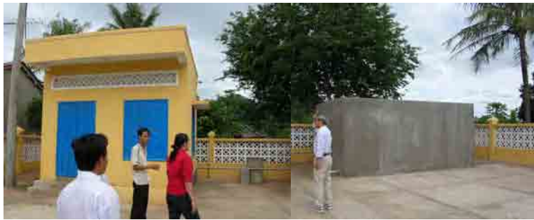
<P-5 Son Phuoc> Thiết bị xử lý nước
