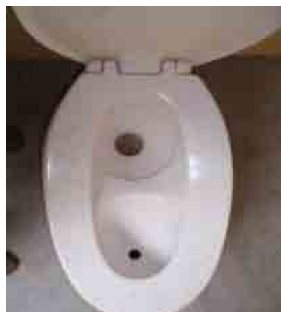
Pour Flush with Septic Tank
