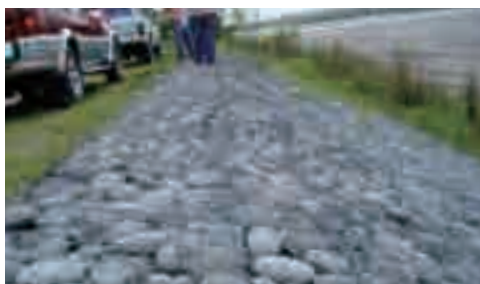
タルラック川右岸堤防修復
