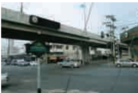
建設された高架橋
