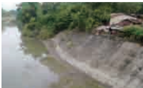
シノカラ川護岸工事
